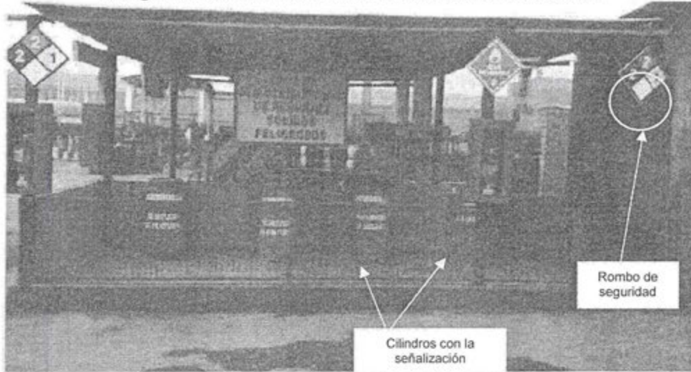
Fotografía N° 3: Vista frontal del Almacén de Residuos Sólidos
