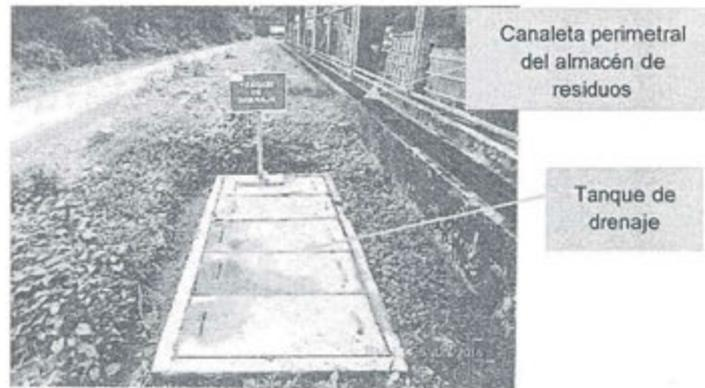
aprecia canaleta perimetral del almacén de residuos de Malvinas, así como tanque de drenaje debidamente señalado.
