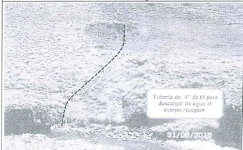
Vista panorámica del recorrido de la tubería de cuatro pulgadas de diámetro, desde la bocamina sellada hasta la descarga en el río Paratia
