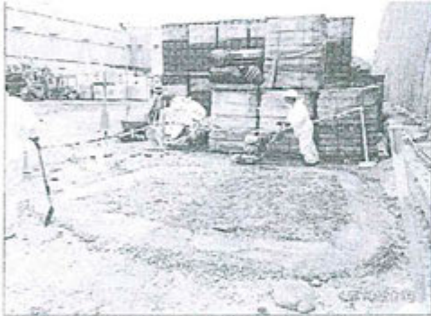
Foto N° 14: Compactación del área excavada
