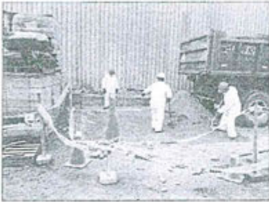
Foto N° 12: Esparcimiento de material para afirmado sobre el área excavada
