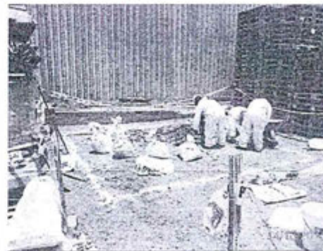
Foto N° 9: Llenado de material contaminado en sacos de polipropileno
