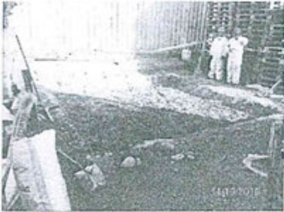
Foto N° 10: Área contaminada totalmente removida dentro del perímetro delimitado
