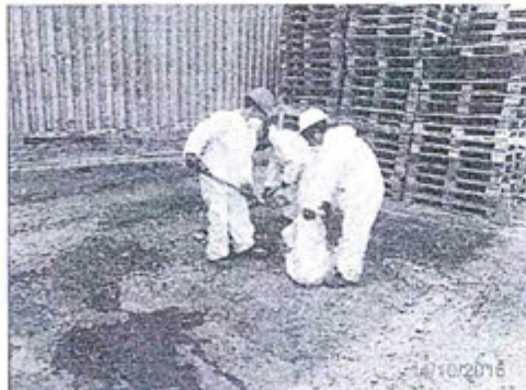
Foto N° 8: Llenado de material contaminado en sacos de polipropileno
