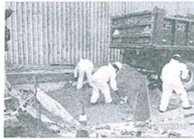
Foto N° 11: Esparcimiento de material para afirmado sobre el área excavada
