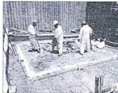
Foto N° 7: Remoción de tierra contaminada
