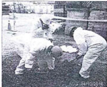
Foto N° 6: Remoción de tierra contaminada
