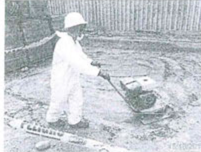
Foto N° 13: Regado y compactación del área excavada
