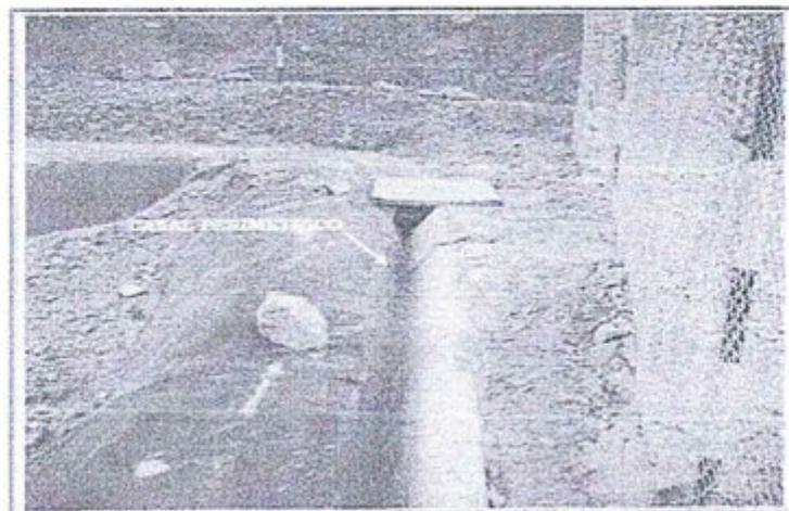
FOTOGRAFIA N° 152.- Canales perimétricos en el relleno sanitario (Recomendación N° 11, Supervisión Regular 2012).
