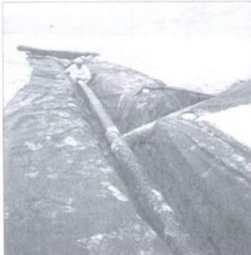
Colocación de filtro, material utilizado de cantera Airas, previamente tamizado
