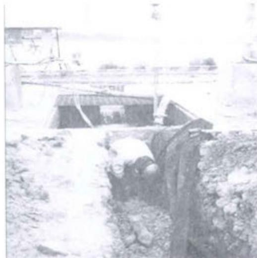
Drenaje de aguas a través del dren principal (tubería) hacia la poza de sedimentación y bombeo
