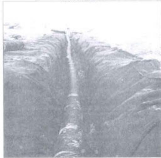
Instalación tubería de HDPE corrugada y perforada en los subdrenes principal y secundarios
