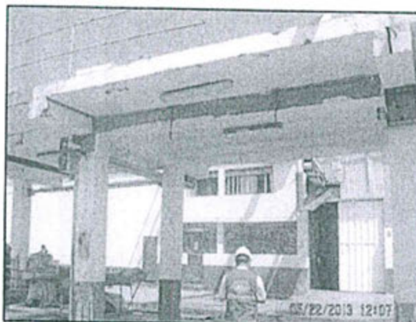
Foto N° 6. Vista del área donde estaban instaladas las centrifugas y separadoras de sólidos.
