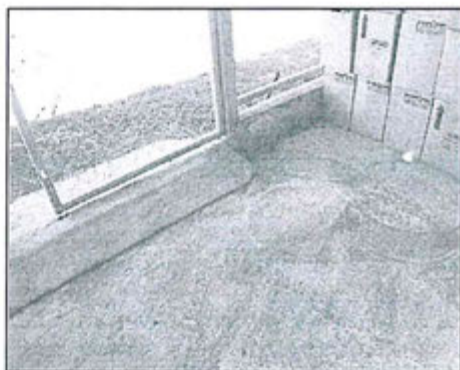
Fotografía N° 21 de la Supervisión del 2014: Se verificó en el almacén de residuos sólidos peligrosos no cuenta con pisos lisos de material impermeable y resistente
