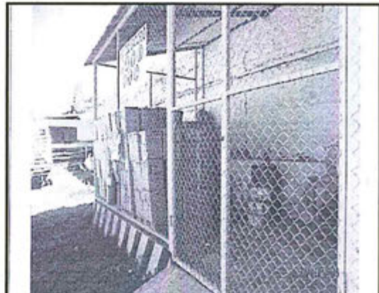
Fotografía N° 22 Se observó que el almacén central de residuos sólidos peligrosos no cuenta detrás y hallazgo de lavados.
