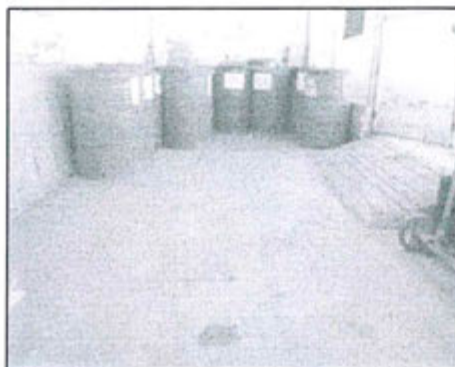
Fotografía N° 9 de la Supervisión del 2012: Almacén de residuos sólidos no cuenta con piso liso e impermeabilizado.
