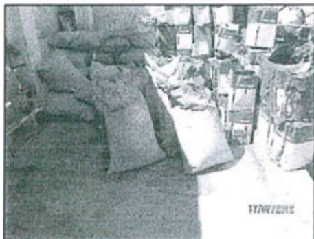
Fotografía N° 21 de la Supervisión del 2014: Se verificó en el almacén de residuos sólidos peligrosos no cuenta con pisos lisos de material impermeable y resistente
