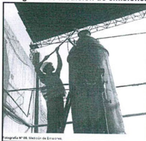
Fotografía N° 08. Medición de Emisiones.
