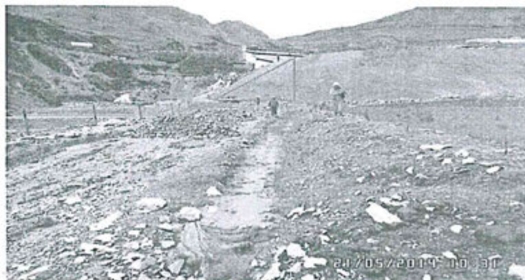
Fotografía N° 4: Lado norte de la plataforma superior del ADRC, donde se observa que el talud tiene una gradiente aproximada de 1H:1V.
