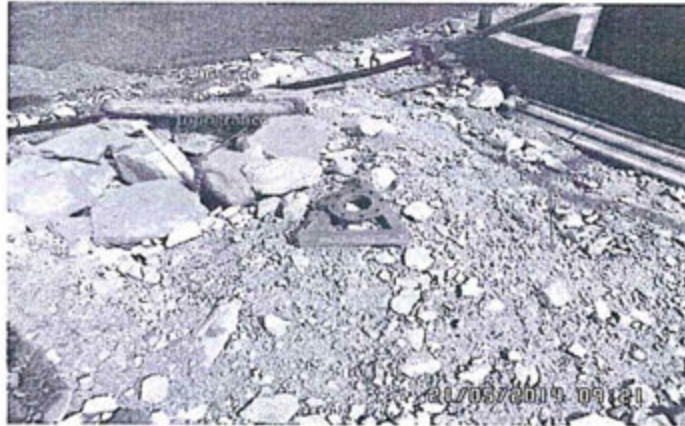
Fotografía N° 61: Lado suroeste de la plataforma superior no cubierto con arcilla y suelo vegetal. Se observa un punto de monitoreo topográfico y residuos de metal.
