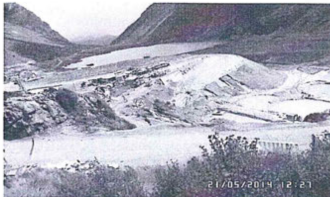
Fotografía N° 6: Plataforma superior del ADRC no revegetado, donde no observa líneas férreas y carros mineros, así como un acceso construido con pendiente negativa.
