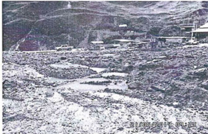
Fotografía N° 46: Plataforma superior donde se ha acumulado suelo orgánico y no se ha uniformizado. Se observa agua acumulada.
