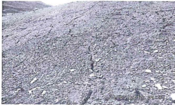
Fotografía N° 68: Talud oeste con grietas de la plataforma superior.
