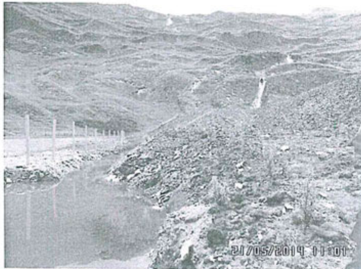
Fotografía N° 45: Canal de escorrentía construido en el pie del talud de la plataforma inferior, dentro del cual se ha observado vegetación y agua estancada.
