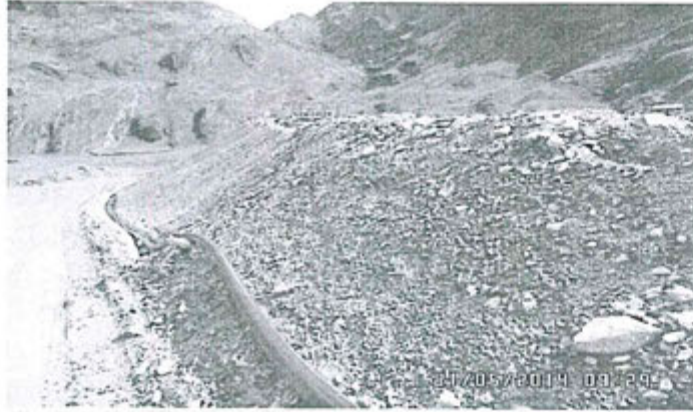
Fotografía N° 10: Talud sur de la plataforma superior del ADRC, no se encuentra revegetado.
