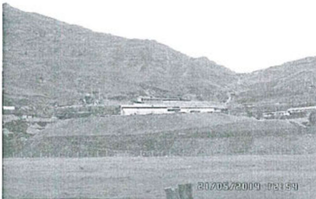
Fotografía N° 48: Vista frontal del ADRC, se observa que los taludés que han sido cubiertos con suelo orgánico pero falta revegetarlos.
