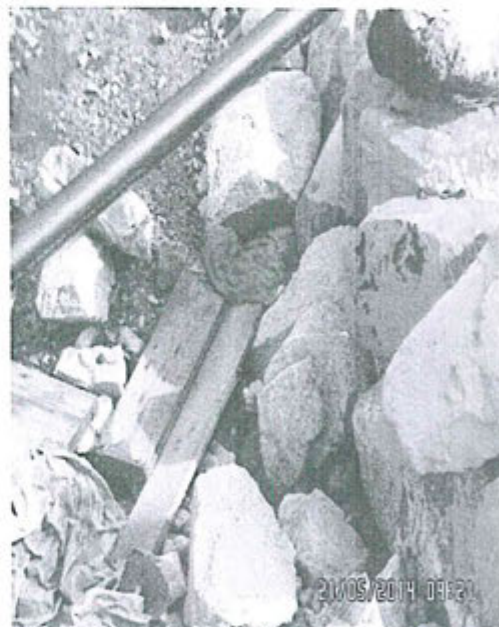
Fotografía N° 71: Residuos de madera y trapos sobre la plataforma superior.
