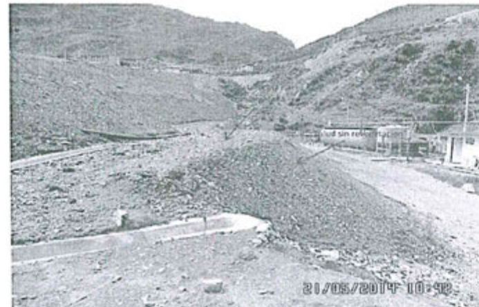
Fotografía N° 12: Plataforma y talud sur de la plataforma inferior, no se encuentran revegetados.
