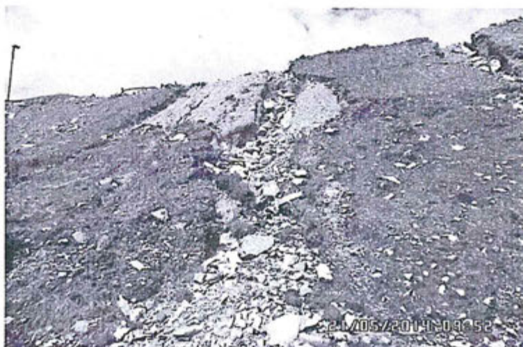
Fotografía N° 9: Talud norte de la plataforma superior, se encuentra erosionado.
