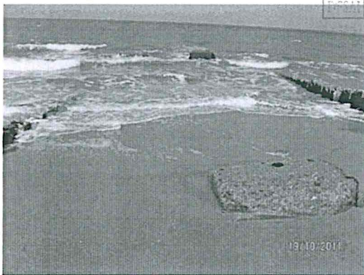
Fotografía N° 1: Infraestructura en el lecho marino
