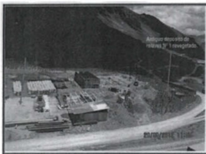
FOTOGRAFÍA N° 07 - Otra vista del Depósito de relaves N° 1. Se observó que sobre el área revegetada de una parte del antiguo depósito de relaves N° 1, el titular minero está ejecutando obras civiles para la construcción del nuevo almacén en la planta concentradora (losa de concreto). Observación N° 5 - 2012.
