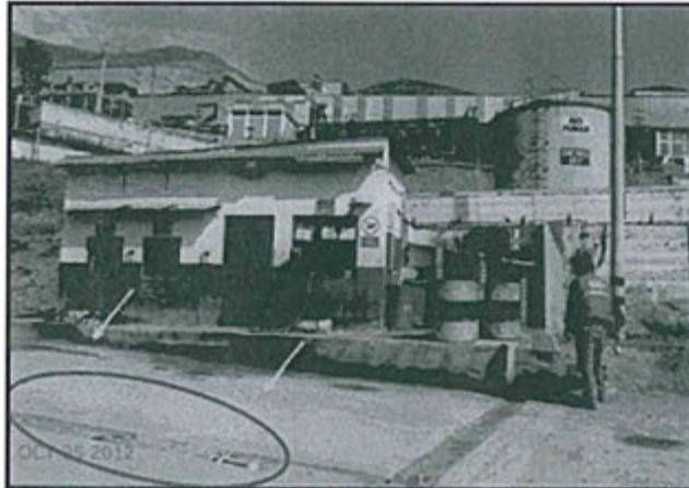
**Fotografía N° 122 del Informe de Supervisión:** Se observó que el suelo de losa de concreto construido se encuentra impregnado de hidrocarburos por derrames. Los sistemas de alcantarilla para la contención de derrames de combustibles se encuentran inconclusos y rotos en algunos sectores.
