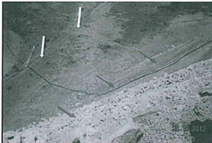
**Fotografía N° 87 del Informe de Supervisión:** Vista de parte del talud del depósito de desmonte Raúl (flechas rojas) y canal de coronación (flechas amarillas) de dicho depósito. En este tramo supervisado el canal se encuentra parcialmente cubierto con sedimentos.
