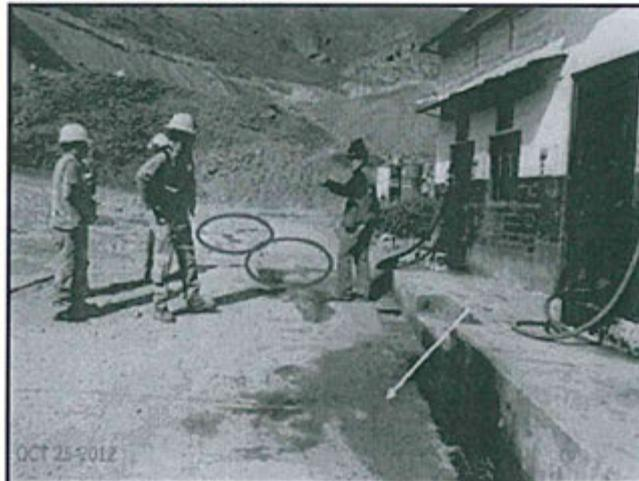
**Fotografía N° 123 del Informe de Supervisión:** Vista de la losa de concreto impregnada de hidrocarburos por derrames. También se observan suelos impregnados de hidrocarburos.
