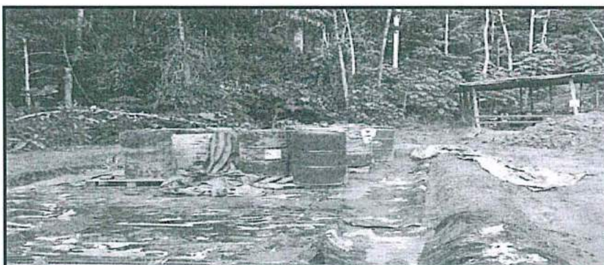
Fotografía N° 11: Cilindros con metanol Kinteroni Cerca del área de mantenimiento se observó 15 cilindros con metanol sobre área con geomembrana, pero que uno de los lados no tiene muro.
