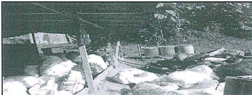
Fotografía N° 12: Se observa el almacén central de residuos completamente lleno y solo una parte bajo techo; el resto se encuentra afuera apilado en desorden.
