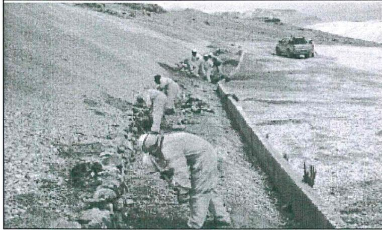
Fotografía N° 1: Vista de los trabajos de reconfiguración del canal de coronación del depósito de desmontes.
