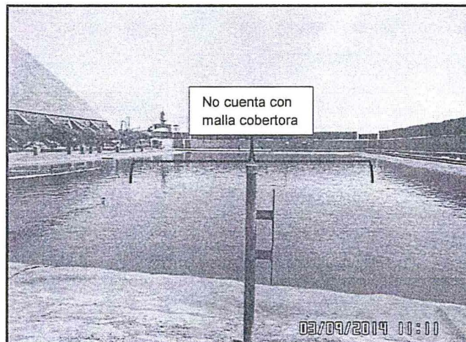
Fotografía N° 40 del Informe de Supervisión: Vista panorámica de la poza de efluentes. No cuenta con malla cobertora. Consignado en el Hallazgo N° 1. Ubicado en las coordenadas UTM WGS 84: N 8 882 071, E 809 307.
