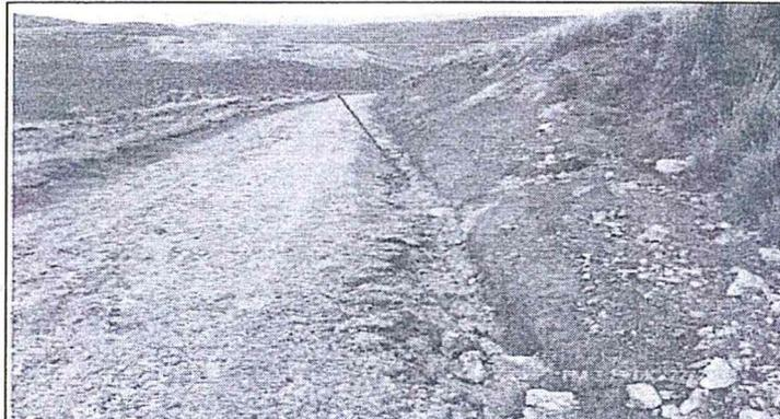
Fotografía N° 49.- Observación N° 3, Vista de la cuneta del acceso a la plataforma CORI-196 colmatada con materiales gruesos.
