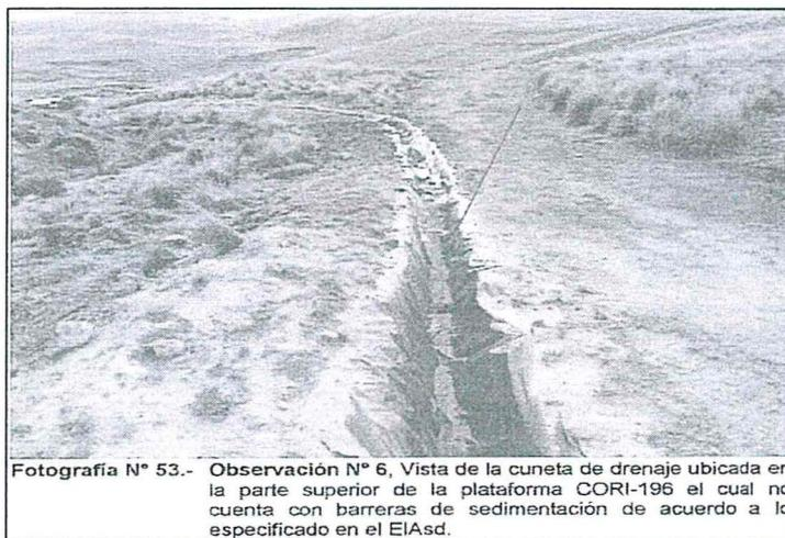
Fotografía N° 53.- Observación N° 6, Vista de la cuneta de drenaje ubicada en la parte superior de la plataforma CORI-196 el cual no cuenta con barreras de sedimentación de acuerdo a lo especificado en el EIASd.
