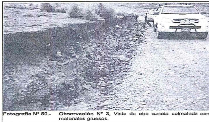
Fotografía N° 50.- Observación N° 3, Vista de otra cuneta colmatada con materiales gruesos.
