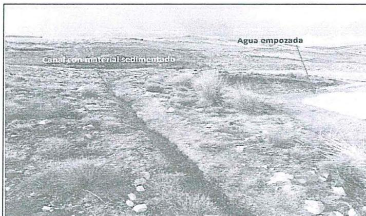
Fotografía N° 7.- Canal de derivación de la plataforma CORI-133, encontrándose con falta de mantenimiento, asimismo no se observa las barreras de sedimentación dentro del canal derivación.
