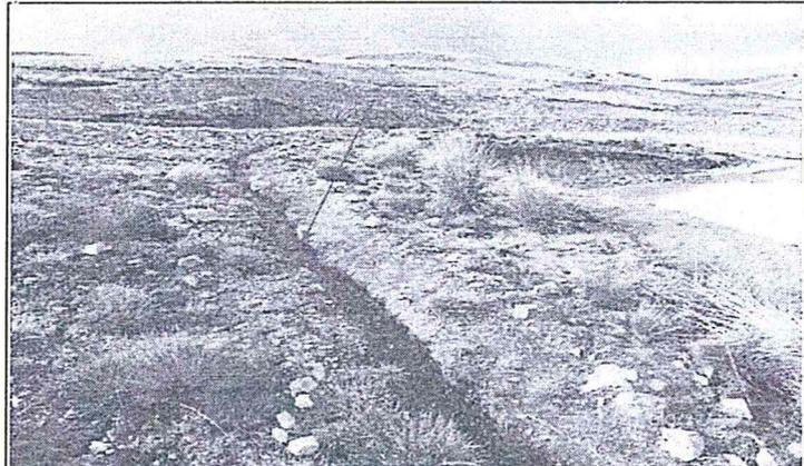
Fotografía N° 54.- Observación N° 6, Vista de la cuneta de drenaje ubicada en la parte superior de la plataforma CORI-133 el cual no cuenta con barreras de sedimentación de acuerdo a lo especificado en el EIASd.
