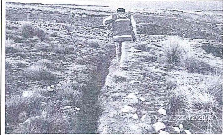
Fotografía N° 51.- Observación N° 4, Vista del canal superior de la plataforma CORI-133, canal construido sobresuelo el cual se encuentra colmatado que permite que las aguas de escorrentía lleguen a la plataforma.
