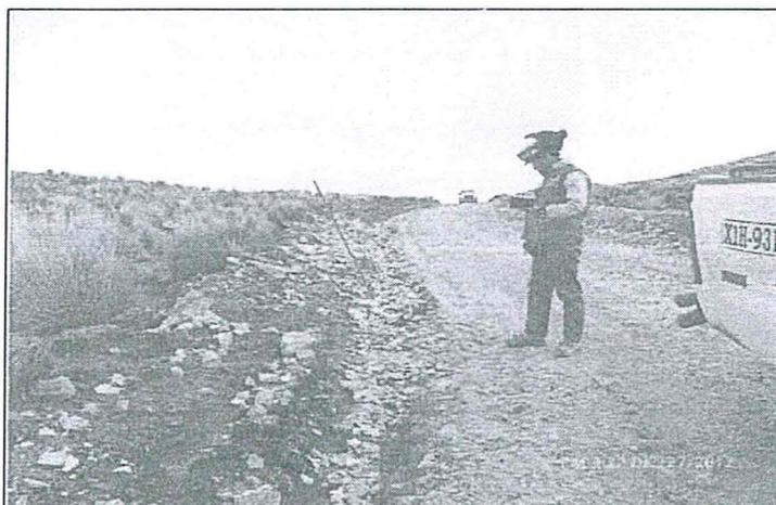
Fotografía N° 20.- Otra vista de la cuneta del acceso CORI-196 colmatada con materiales gruesos.
