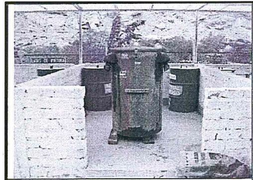
Vista 12. Transformador inservible (residuo peligroso) almacenado junto a otros residuos industriales peligrosos.
