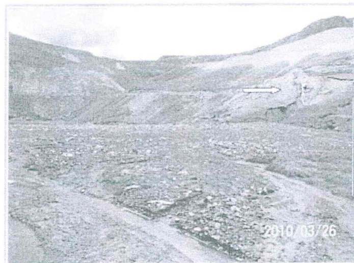
Fotografía N° 31 Canal de coronación en la margen izquierda de la quebrada Rumiallana, el cual ha colapsado y las aguas han erosionado la ladera impactando el bofedal ubicado en el lecho de la quebrada, UEA Cerro de Pasco.
