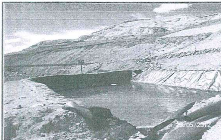
Fotografía N° 88: Hallazgo N° 2. Botadero de Desmonte N° 1. Aguas abajo del botadero de desmonte N° 1 se constató esta poza para la colección del subdrenaje del interior del botadero. Durante la supervisión no se constató el ingreso de agua a la poza.
