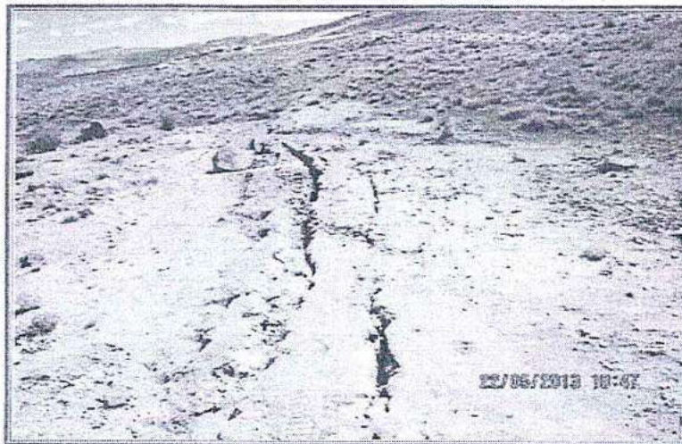
Fotografía N° 117: Observación N° 1. Las grietas se extienden hacia las proximidades de la planta de procesos Andrés.
