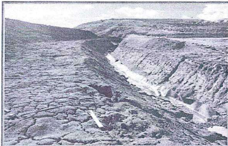
Fotografía N° 111: Hallazgo N° 1. Hallazgo N° 1. Para la derivación de la escorrentía se construyó este canal perimetral en el sector Oeste del Bofedal. Se ha producido un impacto al bofedal, paisaje, suelo y vegetación del área circundante.
