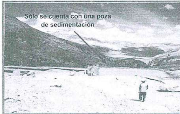
Fotografía N° 40: Hallazgo N° 4 y 5. Sistema de Tratamiento de agua ácida del Tajo y Botadero Jessica. Vista fotográfica de la poza de sedimentación, por la tubería de 12" de diámetro ingresa agua proveniente de la infiltración del Botadero Jessica.
