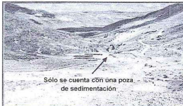
Fotografía N° 38: Hallazgo N° 4 y 5. Sistema de Tratamiento de agua ácida del Tajo y Botadero Jessica. Vista fotográfica de la poza de sedimentación y construcción de las pozas del wetland. En la poza de sedimentación son colectadas las aguas subterráneas del Botadero de Depósito Jessica. No se constató vertimiento del tajo Jessica.
