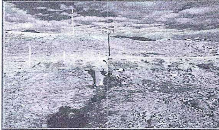
Fotografía N° 180: Punto de control del Efluente T1-01. Ubicado próximo al río Chacapaica, corresponde a la descarga de agua residual doméstica tratada de la planta de tratamiento ubicada cerca al campamento (Zona Baja).
