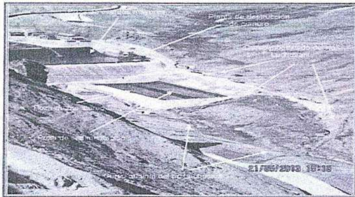
Fotografía N° 124: Hallazgo N° 7. Planta de Beneficio Jessica. Vista fotográfica de la Poza de Eventos Mayores, Planta de Destrucción de Cianuro, Poza de Monitoreo y Sedimentación. La poza de eventos mayores está construido en la proximidad del curso del bofedal y río Luchusani y las pozas de monitoreo y sedimentación sobre el bofedal y curso de agua del río Luchusani. El curso de agua del río Luchusani fue modificado.
