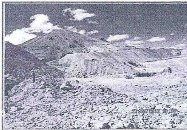
Fotografía N° 17: En la curva del último tramo de la vía de acceso al Tajo Jessica, el canal para la derivación de la escorrentía colectada a la cuenca del río Azufrín, se encuentra en proceso de construcción. En el lugar referido, se constató la presencia del personal que realiza la construcción del canal.
