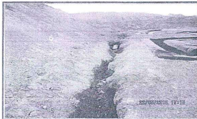
Fotografía N° 85: Hallazgo N° 2. Botadero 3, Sistema de Tratamiento del drenaje y Subdrenaje. Al costado de las pozas wetland, existe este canal por donde el agua habría pasado hacia el río Azufrini.
