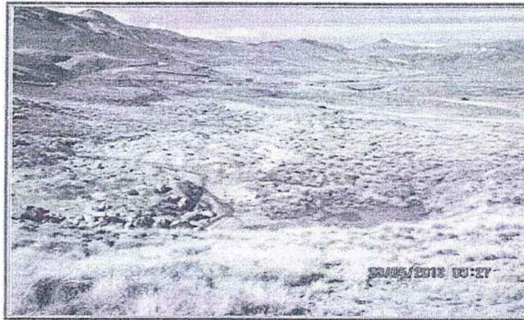
Fotografía N° 68: Hallazgo N° 3. Botadero de Desmonte N° 1. La escorrentía colectada en el canal de coronación es derivada a esta ladera. No se constató la existencia de pozas para la retención de los sólidos arrastrados. El paisaje y vegetación se encuentra impactada.
