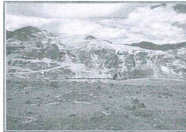
Fotografía N° 19: El agua de escorrentía superficial, colectada en el tramo final del acceso al Tajo Jessica, Lado Oeste, será derivado a esta ladera – parte alta del río Azufrini. Se constató que se encuentra en construcción el canal de derivación e infraestructura para el tratamiento del agua antes de su descarga al curso natural de agua.
