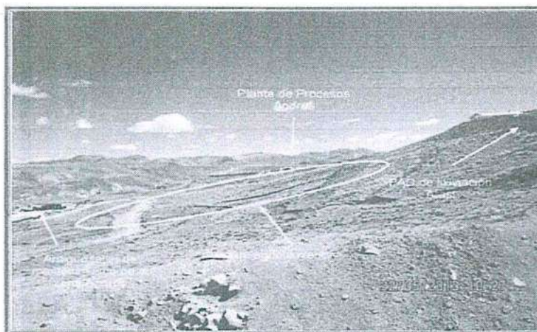
Fotografía N° 114: Observación N° 1. En el área comprendida entre el taller de mantenimiento (antiguo taller de mantenimiento en la zona Andrés), PAD de Lixiviación (Arasi) y Planta de Procesos Andrés (Arasi), se constató un sistema de grietas sobre la superficie. El titular informó que es una subsidencia por el drenaje de agua que están realizando en la ladera de deslizamiento (ladera Oeste del Cerro Jollone) para controlar la estabilidad de toda la zona.
