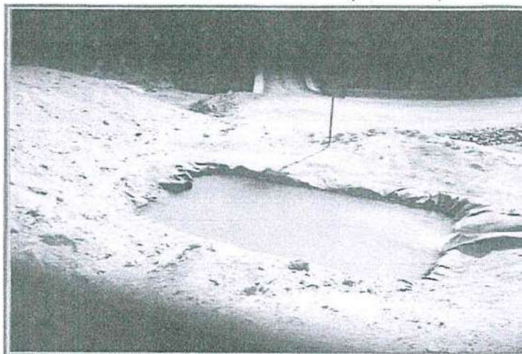
Fotografía N° 89: Hallazgo N° 2. Botadero de Desmonte N° 1. Aguas abajo del botadero de desmonte N° 1 se constató otra poza para la colección del subdrenaje del interior del botadero. Esta agua es descarga al río Chacapalca en donde se tomó una muestra de agua.
