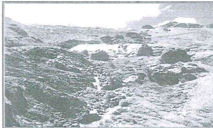
Fotografía N° 43: Hallazgo N° 4 y 5. Sistema de Tratamiento de agua ácida del Tajo y Botadero Jessica. Vista fotográfica de la descarga de agua de la poza de sedimentación al curso natural de agua. Este caudal de agua descargada. Aguas abajo se junta con el cauce de agua de la quebrada Luchusani.
