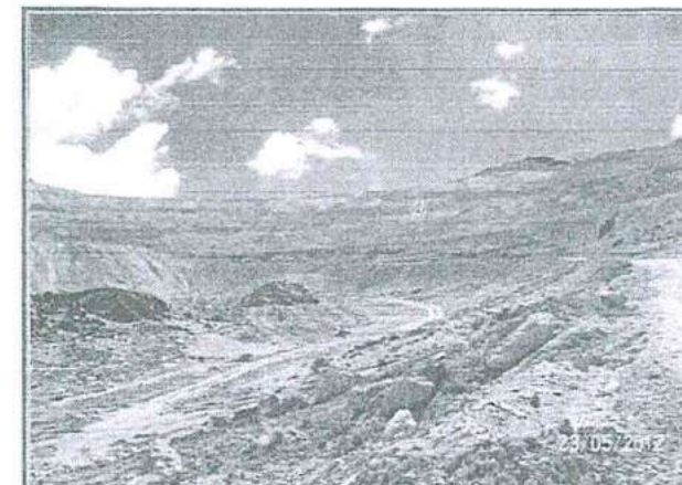
Fotografía N° 35: Hallazgo N° 4 y 5. Sistema de Tratamiento de agua ácida del Tajo y Botadero Jessica. Botadero Jessica, visto desde la parte inferior, cerca al lugar donde se construye el sistema de tratamiento de agua ácida del Tajo y Botadero Jessica.
