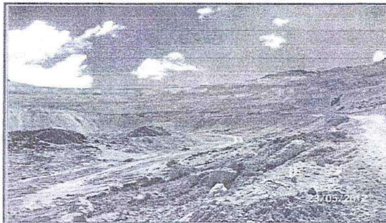
Fotografía N° 35: Hallazgo N° 4 y 5. Sistema de Tratamiento de agua ácida del Tajo y Botadero Jessica. Botadero Jessica, visto desde la parte inferior, cerca al lugar donde se construye el sistema de tratamiento de agua ácida del Tajo y Botadero Jessica.
