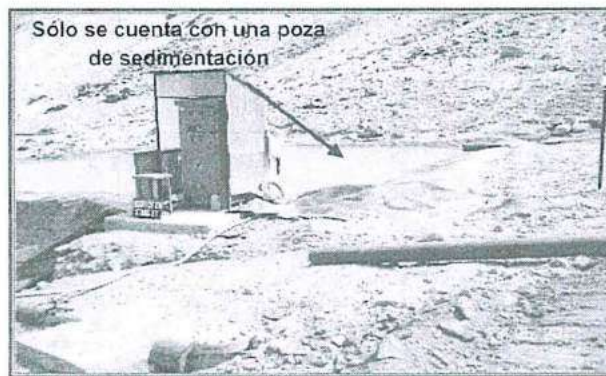
Fotografía N° 41: Hallazgo N° 4 y 5. Sistema de Tratamiento de agua ácida del Tajo y Botadero Jessica. Vista fotográfica de la poza de sedimentación, por la tubería de 12" de diámetro ingresa agua proveniente de la infiltración del Botadero Jessica.
