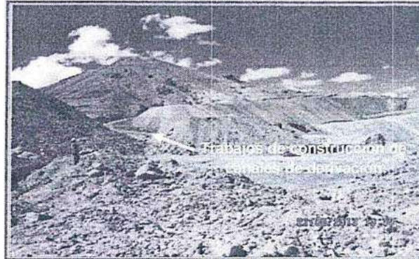
Fotografía N° 17: En la curva del último tramo de la vía de acceso al Tajo Jessica, el canal para la derivación de la escorrentía colectada a la cuenca del río Azufrín, se encuentra en proceso de construcción. En el lugar referido, se constató la presencia del personal que realiza la construcción de canal.
