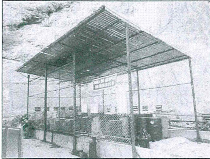
Almacén Temporal de Residuos Peligrosos
