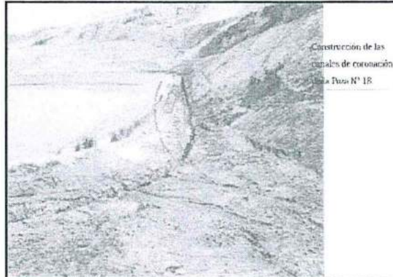
Fotografía N° 10: Construcción de estructuras hidráulicas en el entorno de la poza N° 18 de grandes eventos del Pad N° 14
