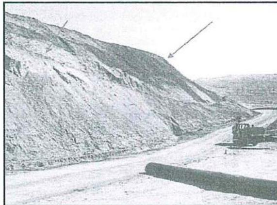
Fotografía N° 14: Se observa banqueteo y perfilado de los taludes del Botadero 08.
