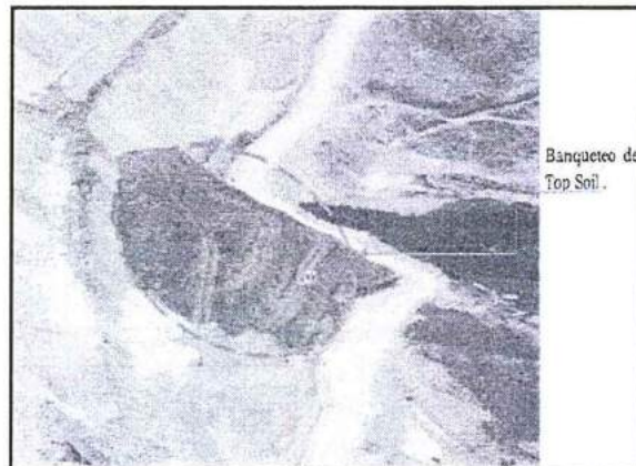
Fotografía N° 2: Trabajos de perfilado en depósito de top soil
