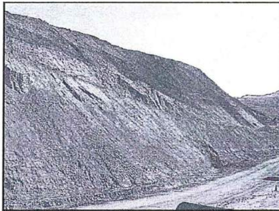
Fotografía N° 117: El Talud del Botadero N° 8 ha sido perfilado y banquetado. Medida Correctiva Hecho Constatado N° 03 y N° 04 - Supervisión Ambiental 2012.
