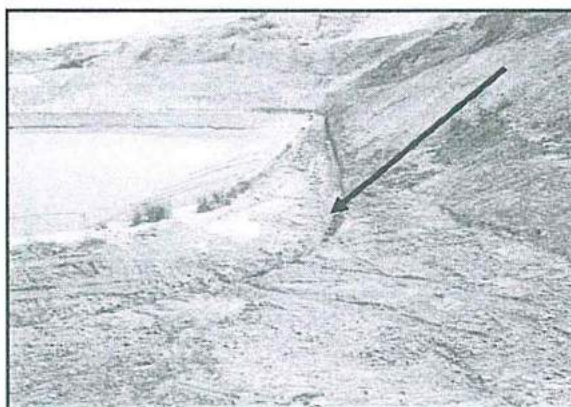
Fotografía N° 30: Construcción de las cunetas de coronación de la Poza 18.
