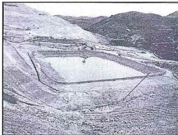
Fotografía N° 122: Estructura hidráulica de la poza N° 18 de grandes eventos. Medida Correctiva Hecho Constatado N° 09 - Supervisión Ambiental 2012.
