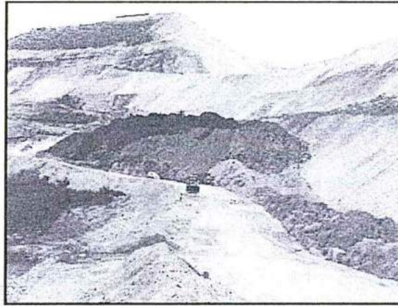
Foto N° 4: Corrección de pendientes de la vía hacia las cunetas.
