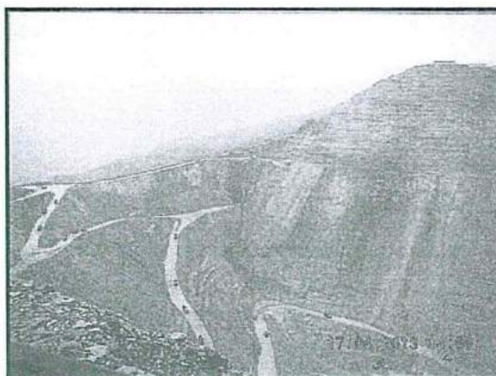
Fotografía N° 115: Se hizo el mantenimiento de las estructuras hidráulicas. Medida Correctiva Hecho Constatado N° 01 - Supervisión Ambiental 2012.
