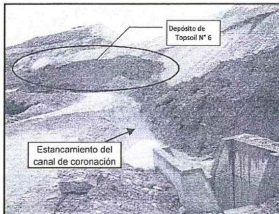
Fotografía N° 4 del Informe de Supervisión: Vista del depósito de top soil N° 6, ubicada sobre una plataforma del depósito de desmonte N° 9, canal de coronación de escorrentías del depósito de desmonte N° 9.
