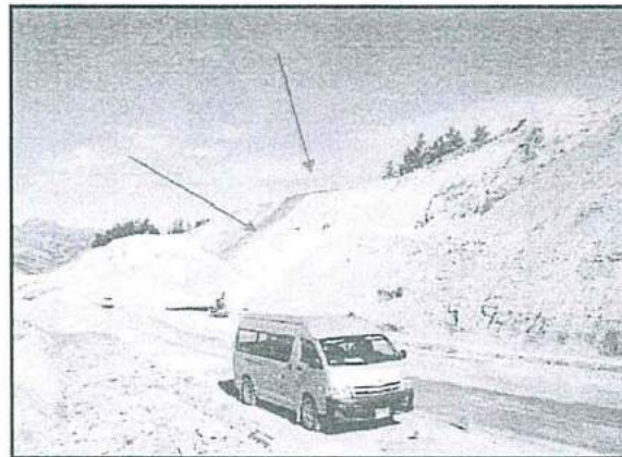
Fotografía N° 15: Otra vista del banqueteo y perfilado del Botadero 08.
