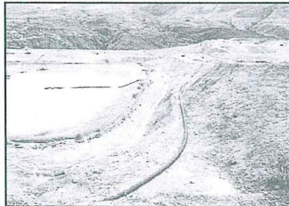
Fotografía N° 21: Estructura hidráulica de la poza N° 19 de Grandes Eventos, después del levantamiento de la observación.
