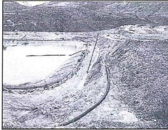
Fotografía N° 119: Estructura hidráulica de la poza N° 19 de grandes eventos. Medida Correctiva Hecho Constatado N° 06 - Supervisión Ambiental 2012.
