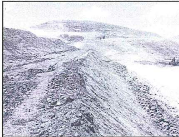
Fotografía N° 11: Detalla de banqueteo del botadero de Top Soil N° 6 y la berma para evitar pérdida de material.
