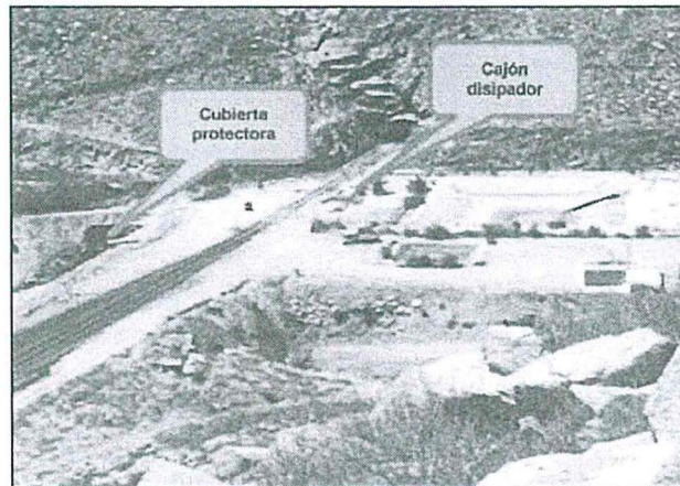
Fotografía N° 3: Ubicación del cajón disipador instalado y la cubierta protectora
