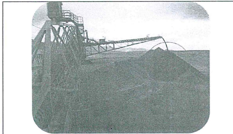
Fotografía N° 3. Vista en primer plano del spreader, nótese que además de la ausencia de material particulado durante las operaciones, el mineral contiene una humedad considerable (círculo de color rojo) debido al sistema de supresión de polvo instalado a lo largo de la faja transportadora.
