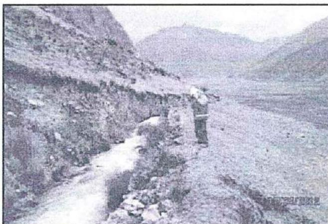
**Fotografía N° 40 del Informe de Supervisión:** Canal de captación de la central hidroeléctrica, no está construido con concreto armado.
