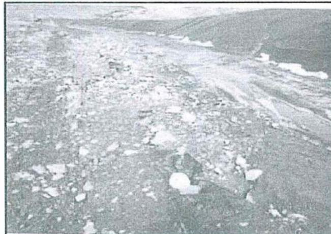
**Fotografía N° 8 del Informe de Supervisión:** Base del vaso del depósito de relaves sin impermeabilización completa.
