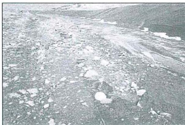
**Fotografía N° 8 del Informe de Supervisión:** Base del vaso del depósito de relaves sin impermeabilización completa.
