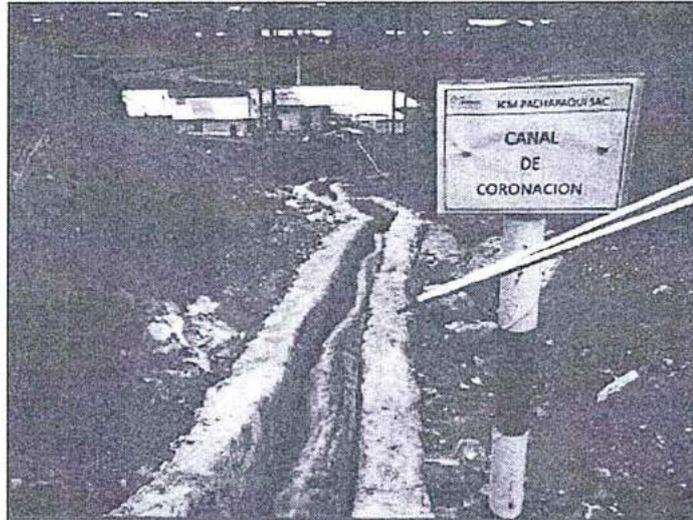
Fotografía 1: Vista Aguas abajo del canal de coronación de mampostería Con concreto lado sur.
