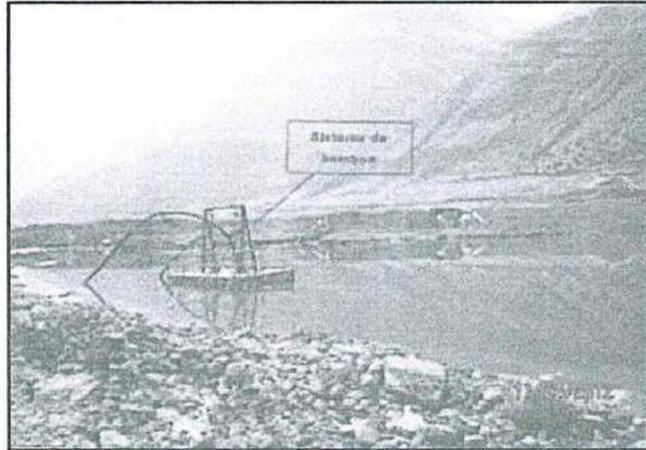
Fotografía N° 11 del Informe de Supervisión: Sistema de bombeo para controlar las aguas del estanque del depósito de relaves.
