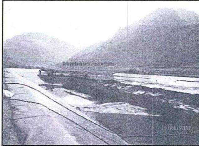
**Fotografía N° 5 del Informe Supervisión:** Depresión donde se acumularon las aguas y generaron presión hidrostática, cuya base no se encuentra impermeabilizada.
