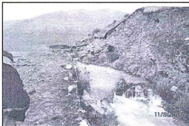
**Fotografía N° 41 del Informe de Supervisión:** Canal de captación de la central hidroeléctrica, no está construido con concreto armado.
