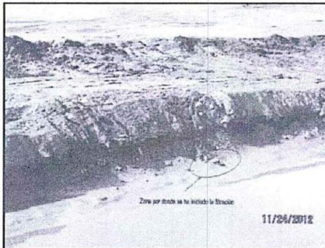
**Fotografía N° 6 del Informe de Supervisión:** Zona donde se ha producido la filtración de relaves hacia la tubería de subdrenaje.
