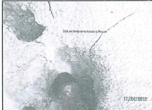
**Fotografía N° 7 del Informe de Supervisión:** Zona por donde se ha producido la filtración de relaves hacia la tubería de subdrenaje, cuya base no está impermeabilizada.
