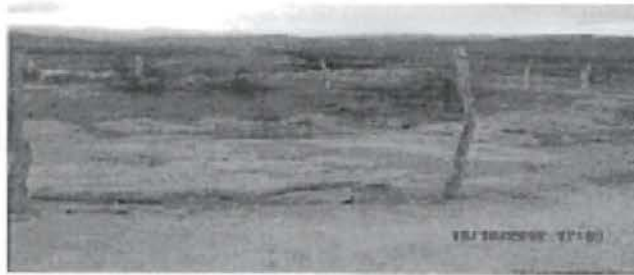
Descripción: El Relleno Sanitario de Residuos Orgánicos protegido por una cerca rústica con alambres y troncos de madera. Coordenadas UTM 9268400 N y 678731 E.
