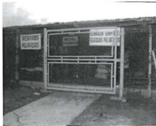
Fotografía N° 1: Almacén Temporal de Sólidos Peligrosos de Estación 7.
