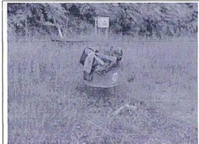
Fotografía N° 14: 01 recipiente (de 42 gal. de cap.) con residual de lubricante a la intemperie – Locación de Pozos24-27 – Capahuari Sur – Lote 1AB.
