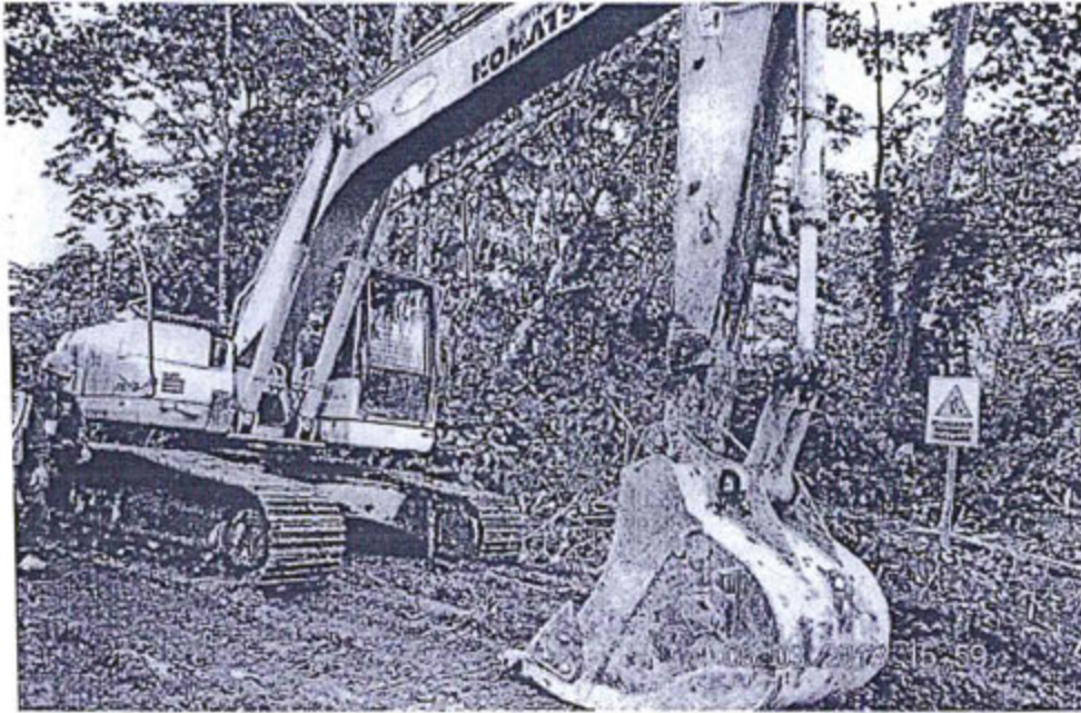
Fotografía 10 (a): El día martes 05-Mar-2013, se encontró a los trabajadores de Corpesa realizando las labores encomendadas por Pluspetrol Norte (según declaraciones del jefe de obras). Estas labores consisten en remover el suelo impactado y "chalar" el gramalote. Se evidenció la presencia de arena sobre el suelo removido.
