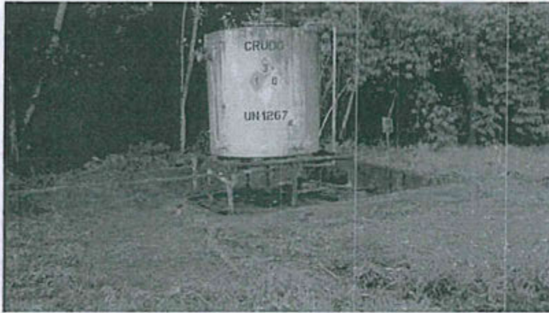
Dique se encuentra limpio y libre de maleza.
