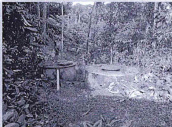
FOTO N° 67: E334010 N9702600 (PSAD 56) / Tanques que almacenan los efluentes líquidos domésticos de Capahuari Norte.
