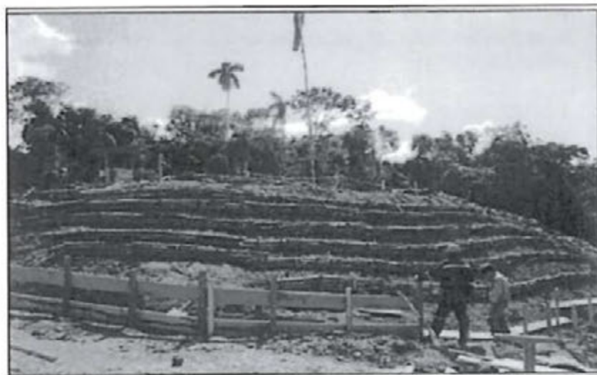
Fotografía N° 13: Trabajos de construcción de trincheras en los depósitos de topsoil
