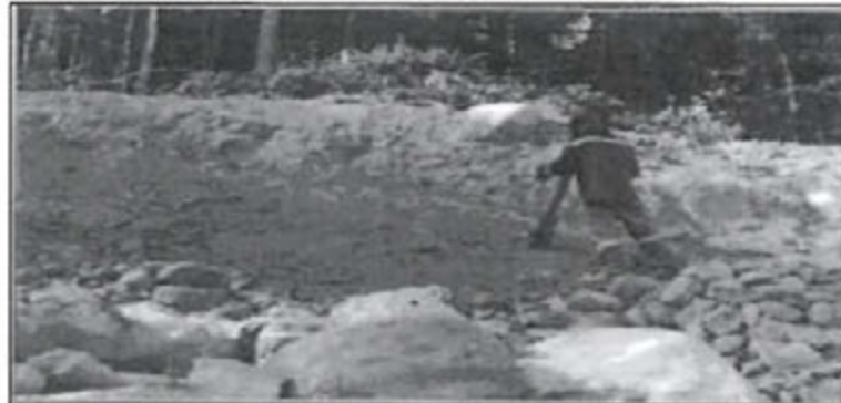
Fotografía N° 9: Trabajos de mejoramiento, compactación y perfilado del talud.
