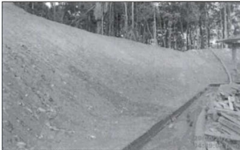
Fotografía N° 18: Canal perimetral de la plataforma de perforación colmatado con sedimentos de talud erosionado. Locación de Perforación Mapi LX.
