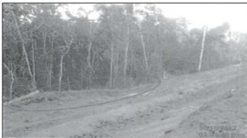
Fotografía N° 28: Segundo montículo de topsoil no cubierto, que lo protege de la erosión ocasionada por la lluvia. – Locación de perforación Mashira GX.
