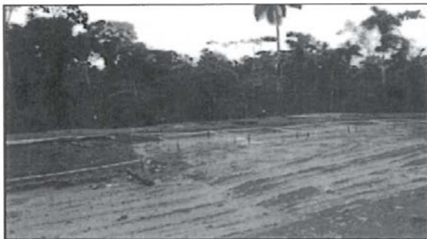
Fotografía N° 12: Delimitación de las celdas de cortes de perforación
