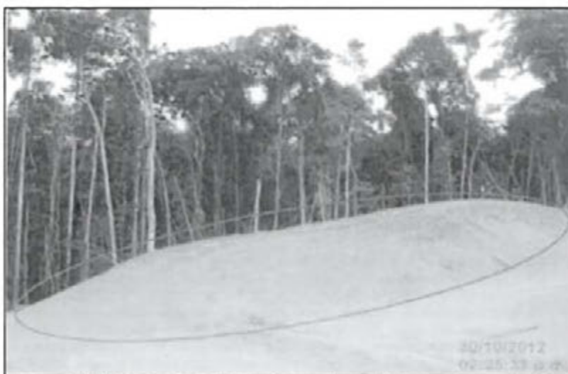
Fotografía N° 29: Tercer montículo de topsoil no cubierto, que lo protege de la erosión ocasionada por la lluvia. – Locación de perforación Mashira GX.
