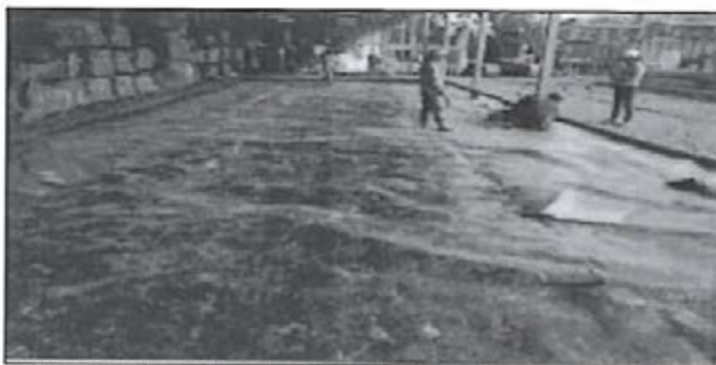
Fotografía N° 6: Trabajos de renovación de geomembrana utilizada en el piso del almacén de químicos.
