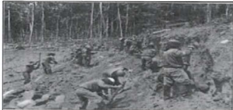
Fotografía N° 8: Trabajos de mejoramiento y perfilado del talud
