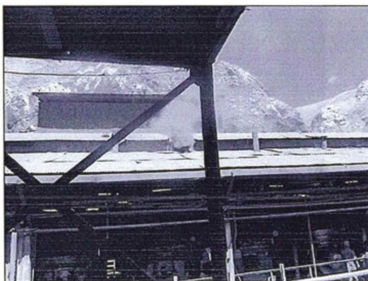
Hallazgo N° 9: Fotografía N° 45: Emisiones de gases por la chimenea de la quinta retorta de la planta de polvo de zinc.
