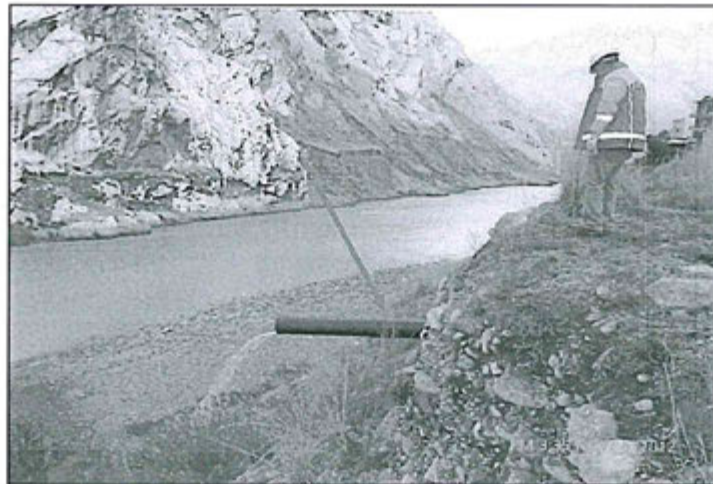
Hallazgo 79: Fotografía N o 105: Parte baja del campamento SUDETE, donde existe una tubería de 8" de diámetro, por donde se descargan aguas al río Mantaro, sin contar con la autorización de la autoridad competente.
