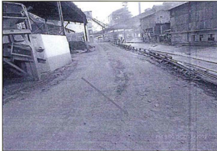
Hallazgo N° 37: Fotografía N° 8: Vía de acceso hacia la planta Zileret y depósito de almacenamiento de concentrados de zinc, donde se realiza riego, por lo que por acción del viento se levanta polvo impactando áreas aledañas y la calidad del aire.
