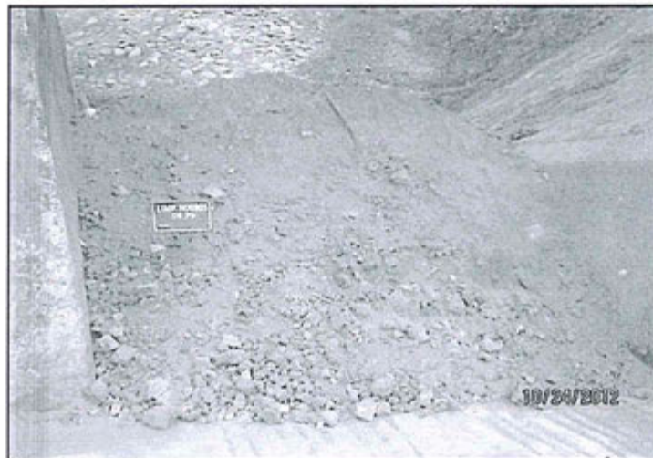
Hallazgo 70: Fotografía N° 91: Almacenamiento de materiales de limpieza de Plomo, no está cubierto y en la zona no existen estructuras hidráulicas
