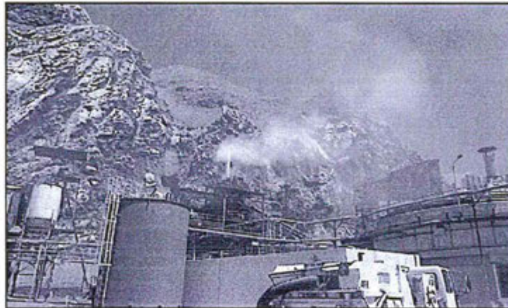
Hallazgo 75: Fotografía N° 51: Emisiones de gases de combustión por la chimenea instalada cerca al horno Kiln
