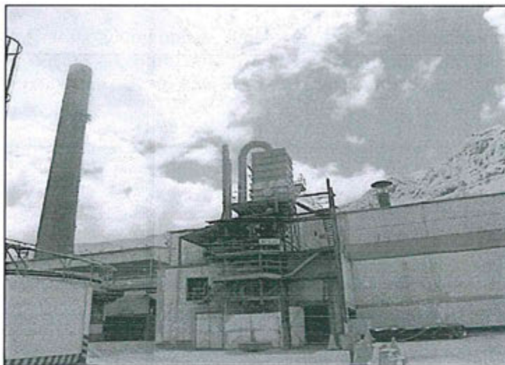
Hallazgo N° 13: Fotografía N° 56: Emisiones de gases por dos chimeneas instaladas en la planta de fusión y moldeo
