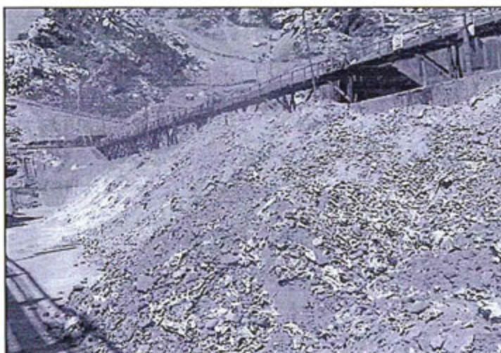
Hallazgo N° 16: Fotografía N° 4: Residuos de purificación de zinc (ZPR) sin cubierta, ubicada al costado del depósito de concentrados de zinc.
