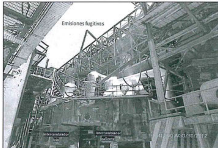
Hallazgo N° 1: Fotografía N° 10: Se observó en los manholes, emisiones fugitivas que salen por las bridas. Esto se encuentra en el intercambiador caliente y frío del Convertidor Catalítico de la planta de ácido sulfúrico de Zinc.
