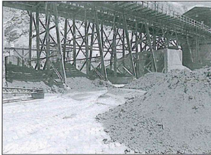
Hallazgo N° 3: Fotografía N° 2: Almacenamiento de concentrados fuera del depósito techado.
