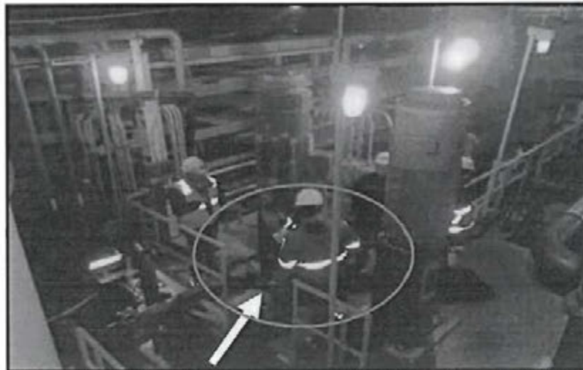
Fotografía N° 5 del Informe de Supervisión.- Válvula Check de ingreso a la piscina de transferencia.
