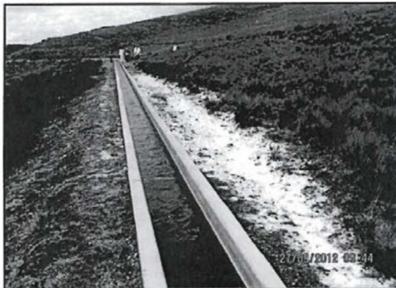
Procedimiento de limpieza del accidente ambiental
