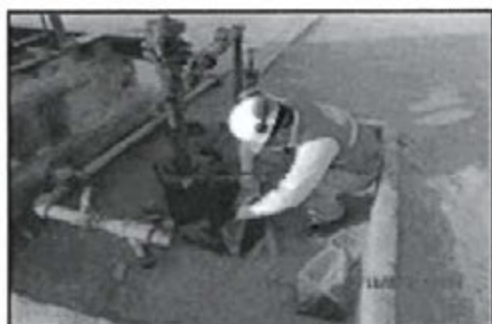
Fotografía N° 35: Pozo 5846, suelo contaminado dentro de la cantina de concreto (SU-03) (491359E, 9535402N)
