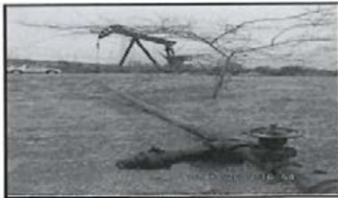
Fotografía N° 45: Pozo 6806, líquido fuera de la válvula a 15 metros del pozo (488650E, 9539534N)
