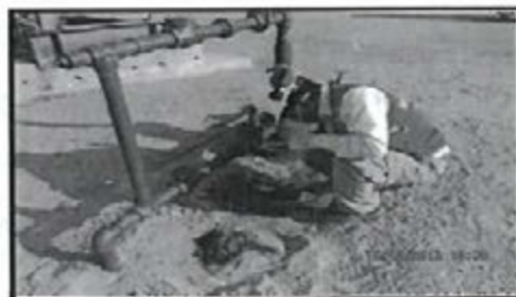
Fotografía N° 14: Toma de muestra de suelos (SU-02) en el Pozo 7029, a la altura del puente de producción (490791E, 9535099N)
