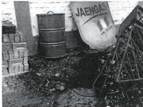
Fotografía N° 10: Ampliación de la Fotografía N° 09.
