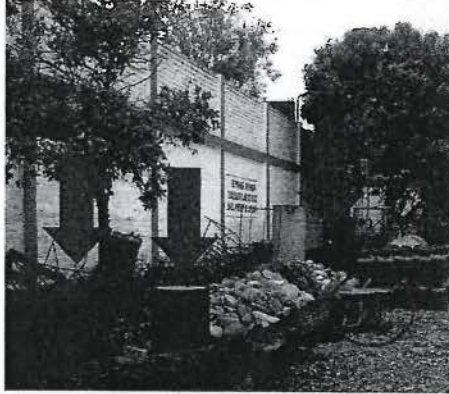
Fotografía N° 12: Ampliación de la Fotografía N° 09.
