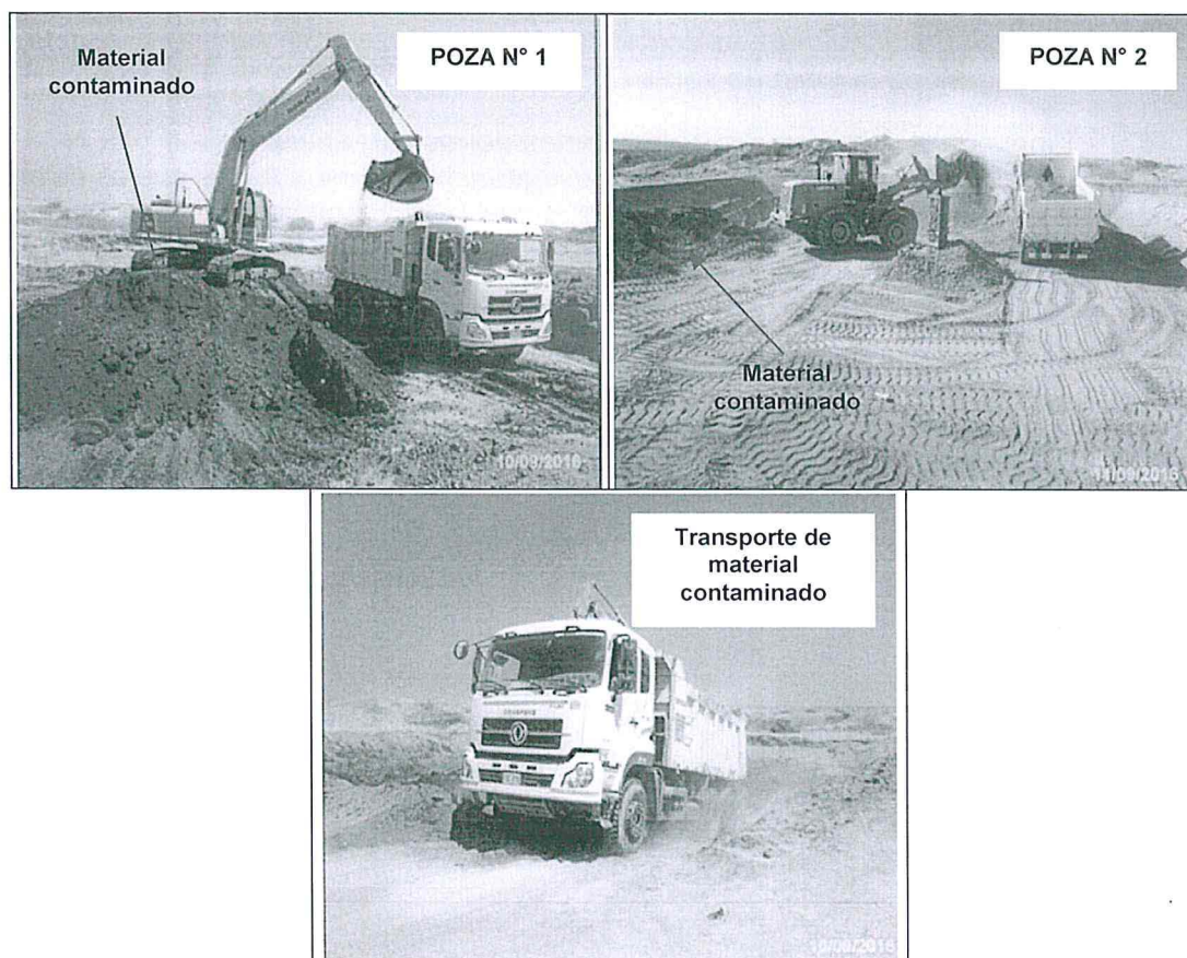
Imagen N° 3: Limpieza y transporte de material contaminado de la Poza N° 1 y Poza N° 2 (10 de setiembre de 2016)
