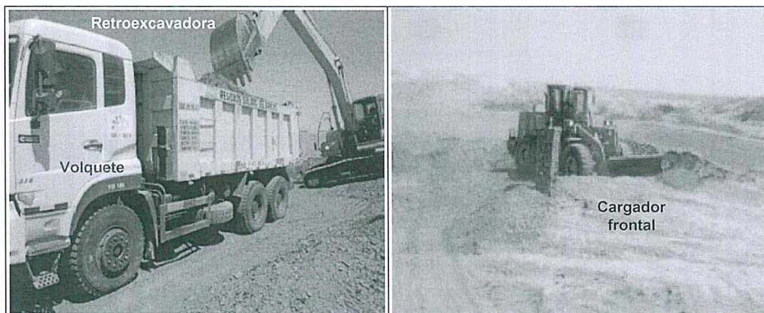
Imagen N° 2: Equipos utilizados para la limpieza de las pozas para residuos
