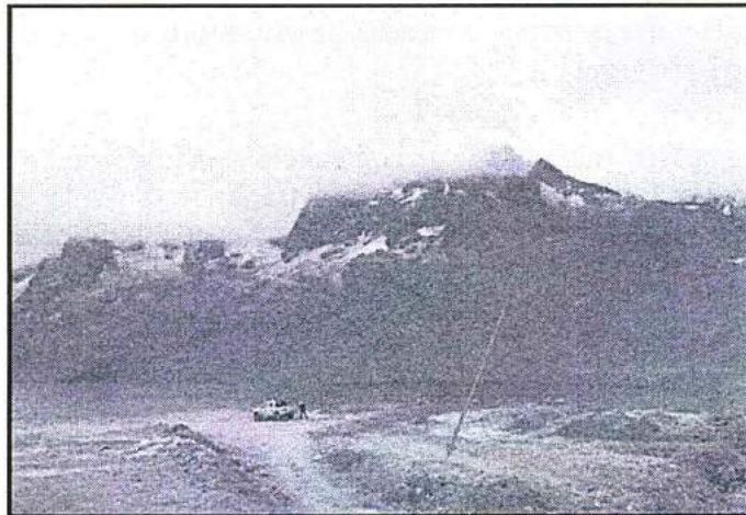
Fotografía N° 23 del Informe de Supervisión.- Depósito de desmonte Tashman de la unidad minera Morococha, en frente se aprecia la Laguna Churruca.
