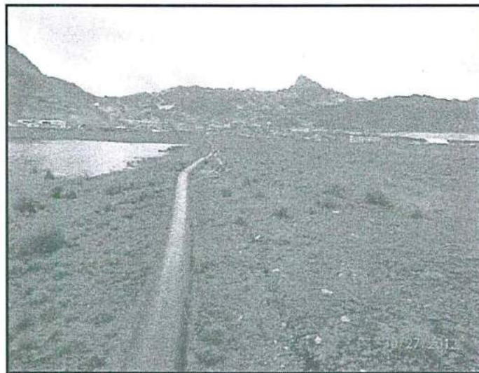
Fotografía N° 12 del Informe de Supervisión.- Otra vista de la tubería que conduce el relave, el cual se encuentra sobre el suelo (altura del distrito de Morococha).
