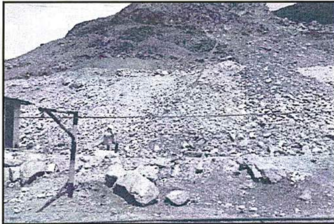
Fotografía N° 17 del Informe de Supervisión.- Se observó que el titular minero viene disponiendo material proveniente de la bocamina Ombla en la zona denominada Cobriza; es decir, viene habilitando la desmontera denominada Cobriza.
