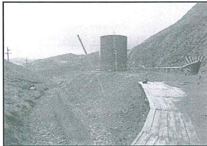
Fotografía N° 33 del Informe de Supervisión.- Depósito de desmonte Sierra Nevada de la unidad minera Anticona. Habilitado directamente sobre suelo natural.
