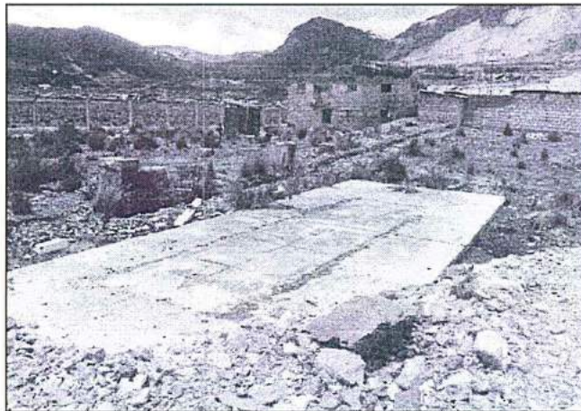
Losa de la ex planta de tratamiento del campamento Morococha vieja
