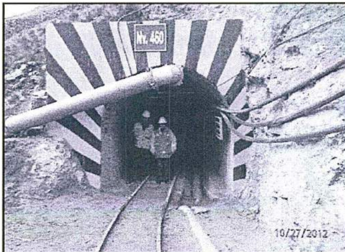
Fotografía N° 10 del Informe de Supervisión.- Bocamina Sierra Nevada Nivel 4460 de la unidad minera Anticona, operativa. Se constató que no salen aguas de mina por la bocamina.
