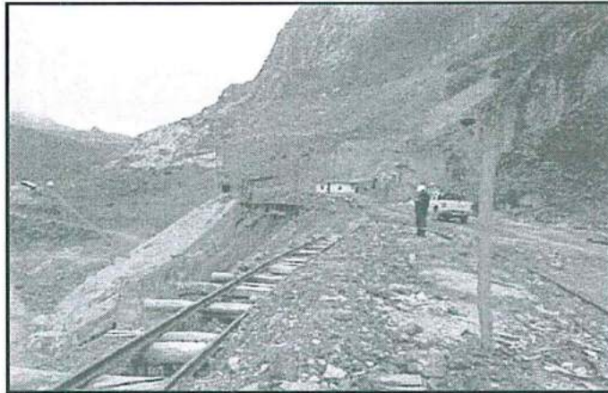
Fotografía N° 29 del Informe de Supervisión.- Desmontera Codiciada de la unidad minera Anticona. Habilitada directamente sobre el suelo.
