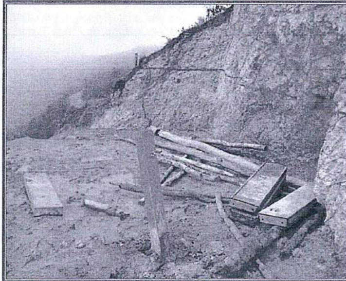
FOTOGRAFÍA N° 42.- Sector Cañariaco Norte. Plataforma DH12-25 emplazada en las coordenadas 690 185 E – 9 326 774 N. cuenta con un piezómetro instalado. La perforación fue realizada entre el 4 y 18 de abril 2013; su plataforma, taludes y pozas lodos no han sido remediados.
