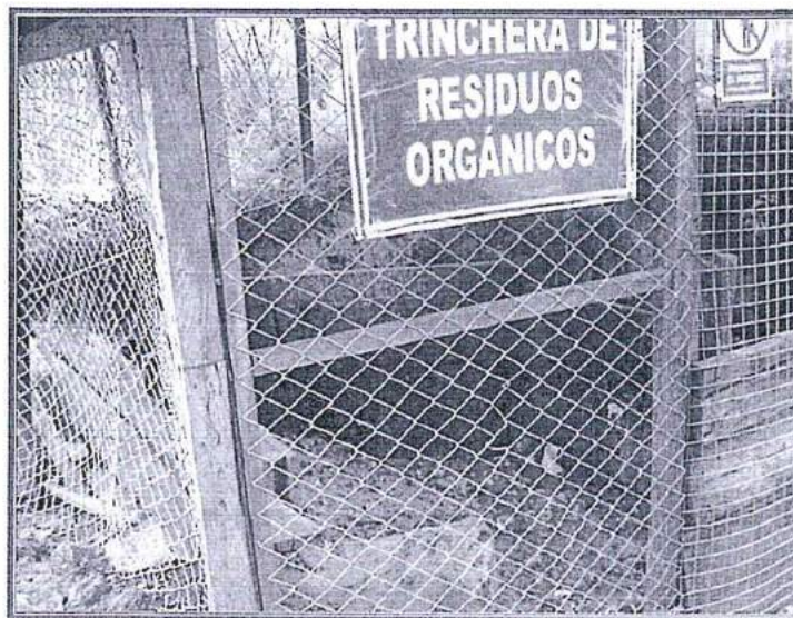
FOTOGRAFÍA N° 75.- Residuos sólidos domésticos dispuestos en la trinchera existente son cubiertos con material orgánico (Aserrín de madera) que no impide la emisión de olores y presencia de vectores.
