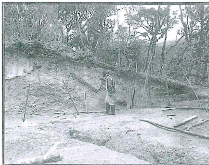
FOTOGRAFÍA N° 49.- Sector Cañariaco Sur. Plataforma X, emplazada en las coordenadas 689 646 E – 9 324 475 N. Fue trabajada entre el 11 y 21 de abril de 2013 y el 23 al 30 de abril de 2013 para la ejecución de los taladros DDH-CS13-011 y DDH-CS13-012, con fines de exploración, no se encuentra remediada.
