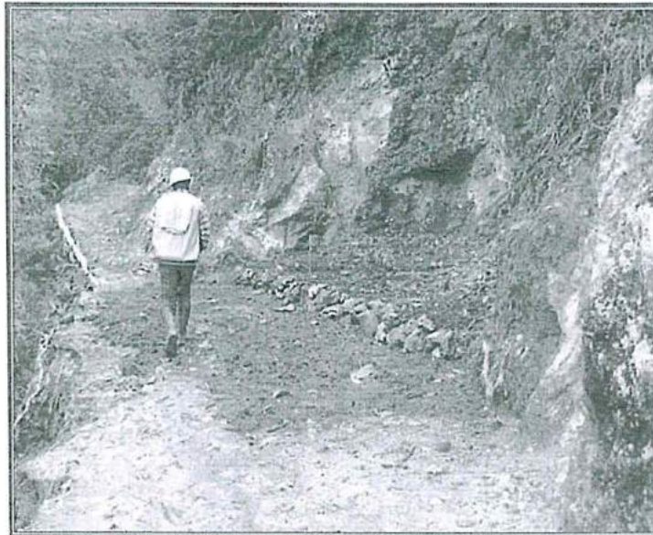
FOTOGRAFÍA N° 45.- Sector Cañariaco Norte. Plataforma antigua usada los años 2004 (C04-008), 2007 (C07-100) y 2012 (C12-05), coordenadas 690 764 E y 9 326 356 N, en ella se perforó entre el 29 de enero y 3 de febrero de 2013 el taladro MET12-05.
