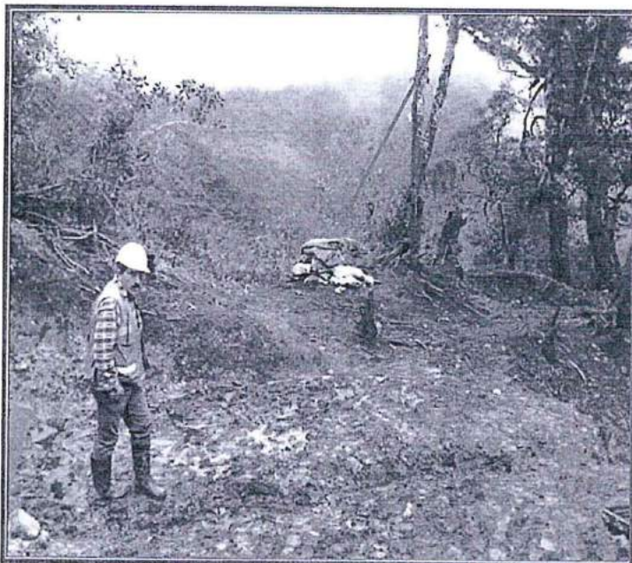
FOTOGRAFÍA N° 70.- Plataforma AMM-G02 (También denominada 07-083) emplazada en las coordenadas 690 926 E – 9 325 610 N. se observa los lodos de la perforación ensacados para su traslado hacia el campamento.
