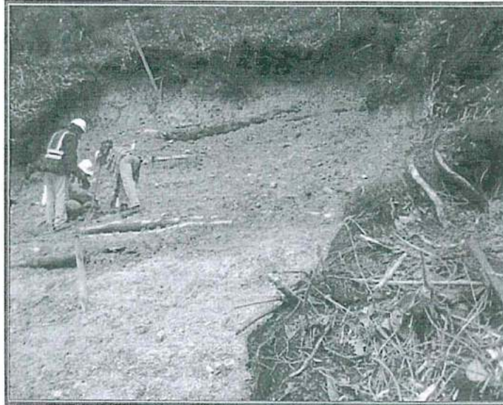
FOTOGRAFÍA N° 53.- Sector Cañariaco Sur. Plataforma P, emplazada en las coordenadas 690 299 E – 9 324 532 N.; en ella se ejecutó el taladro DDH-CS13-010, se encuentra en etapa final de revegetación.
