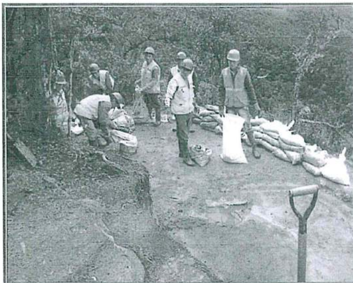
FOTOGRAFÍA N° 67.- Labores de remediación que se vienen haciendo en el sector de la Plataforma AMMG-04 ó DDH-12-06 emplazada en las coordenadas 690 479 E – 9 326 444 N. Se trabaja con personal de la zona en labores exclusivas de ensacado de lodos.
