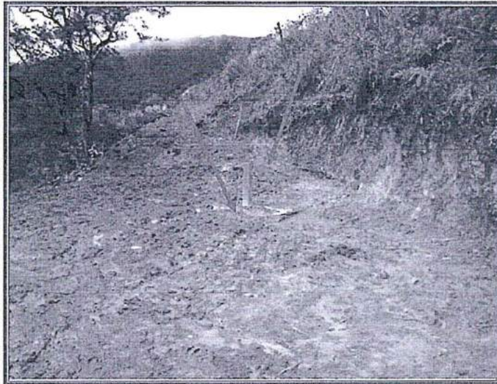
FOTOGRAFÍA N° 54.- Plataforma AMMG-04 ó DDH-12-06 emplezada en las coordenadas 690 479 E – 9 326 444 N. Además del piezómetro instalado tiene un taladro de exploración, no ha sido remediada.
