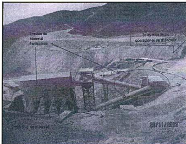
Fotografía N° 162 del Informe de Supervisión: Vista panorámica desde el área de chancado de la Planta Concentradora, se evidencia la emisión de material particulado por acción del viento.
