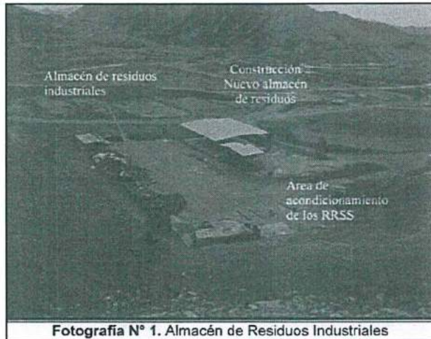
Fotografía N° 1. Almacén de Residuos Industriales
