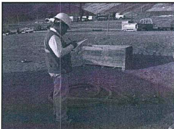
Fotografía N° 159 del Informe de Supervisión: Hallazgo N° 2-2013. En un área adyacente a las instalaciones de la contrata Saturno, en las coordenadas UTM (WGS84): Este 326457 y Norte 8596220, se encontró mala disposición de residuos industriales (pedazos de mangueras, madera y otros).
