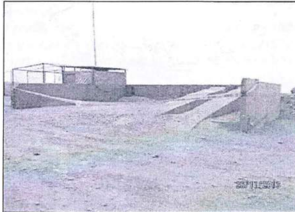
Fotografía N° 4. En la loza destinada al mantenimiento de maquinaria de mina no se evidenció restos de hidrocarburos sobre el suelo ni una disposición inadecuada de residuos sólidos.
