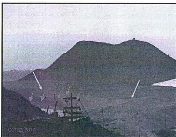
Fotografía N° 14 del Informe de Supervisión: Se observa parte de las tuberías que transportan los relaves provenientes de la planta concentradora "Condestable I", hacia el Depósito de Relaves N° 4 y cajón de distribución (flechas azules).
