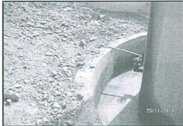
Fotografía N° 3 del Informe N° 350-2015-OEFA/DS-MIN: Vista de la parte posterior del tanque de almacenamiento de combustible. No se evidenció derrames de hidrocarburos.
