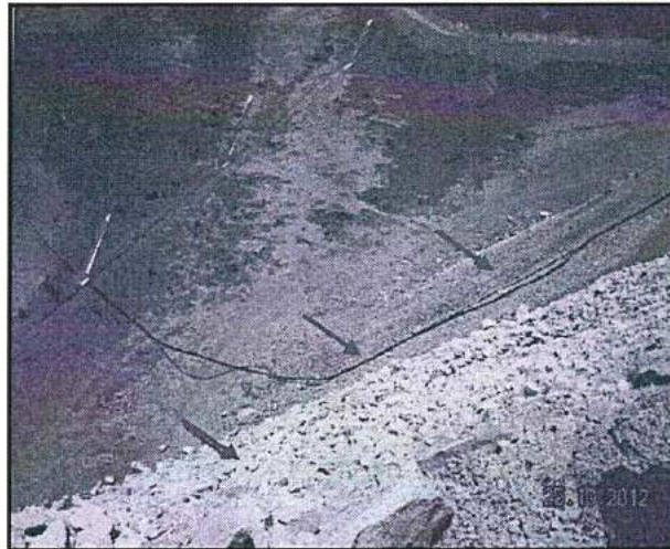
Fotografía N° 87 del Informe de Supervisión: Vista de parte del talud del depósito de desmonte Raúl (flechas rojas) y canal de coronación (flechas amarillas) de dicho depósito. En este tramo supervisado el canal se encuentra parcialmente cubierto con sedimentos.
