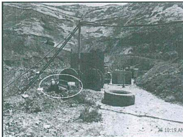
Fotografía N° 141 del Informe de Supervisión: En el Nivel +295 de Mina Condestable. Zona contigua a la losa de concreto. Se observan llantas, residuos y estructuras metálicas que no se encuentran en una zona determinada para su acopio temporal.
