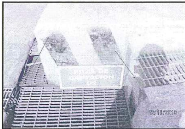
Fotografía N° 2 Informe N° 350-2015-OEFA/DS-MIN: Vista de la limpieza de los canales de drenajes, así como de la poza de captación de los drenajes.
