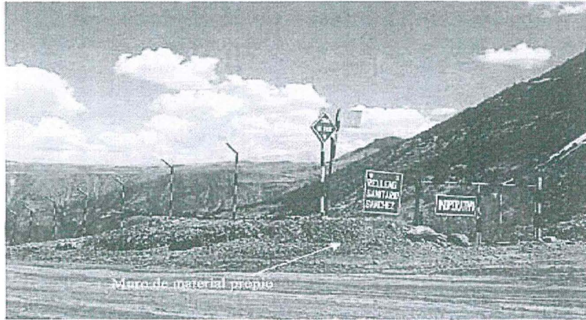
Fotografía N° 14: Muro de material propio
