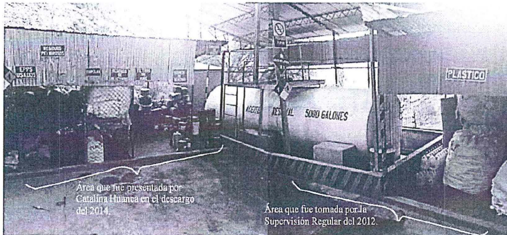
Fotografía N° 11: Vista panorámica del Almacén temporal de Residuos.
