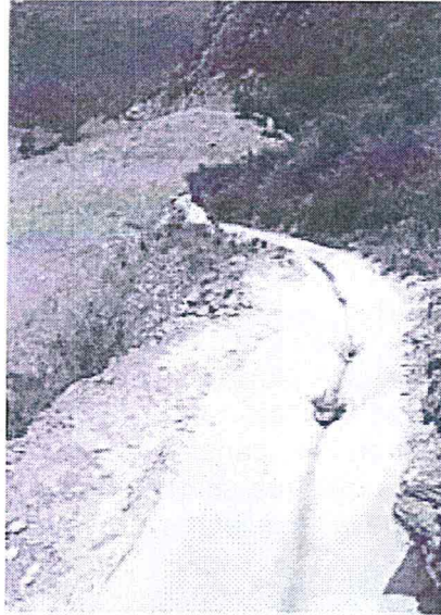
Foto N° 9: Cuneta en forma de "v" que rodea al depósito de relave N°10. Para evitar el ingreso de agua al componente
