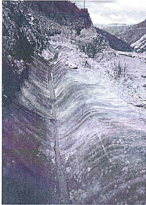
Fotografía N° 6: Canal con geomembrana visto en la supervisión
