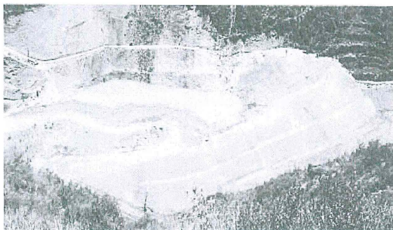
Fotografía N° 9: Vista panorámica del depósito de relave N°10, después del relleno, conformación de terraplén, talud y apertura de vía de acceso
