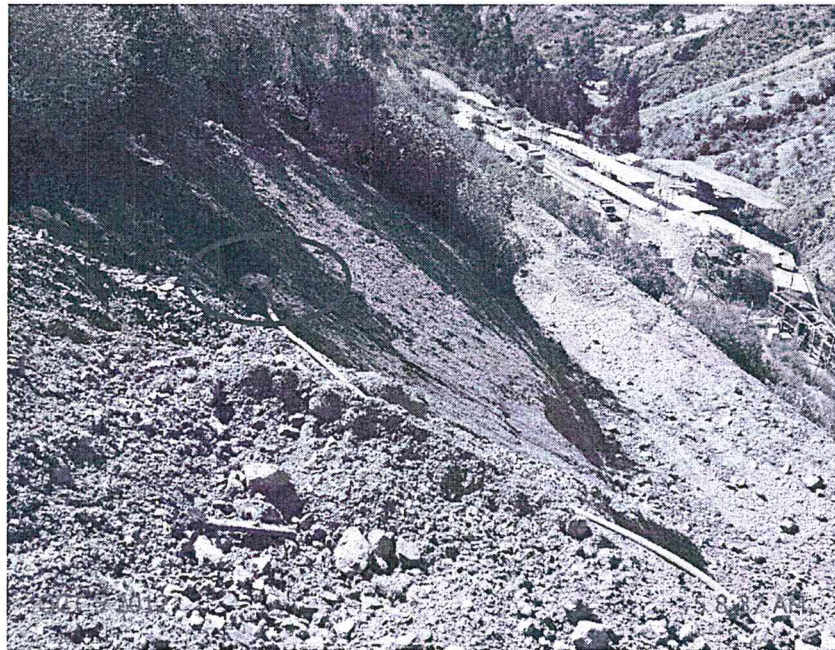
Fotografía N° 87: Supervisión regular 2012. Observación N° 11. El relleno sanitario reubicado de acuerdo a la recomendación 2011, no cuenta con poza de lixiviados, se ha instalado un tanque de plástico (Círculo rojo) de manera provisional para la colección de lixiviados, asimismo no hay acceso hacia el emplazamiento del tanque (Círculo rojo).
