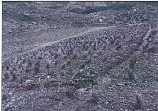
Fotografía N° 29: Se aprecia el caudal de agua más o menos 4 l/seg. Ingresando al tajo originando la erosión.
