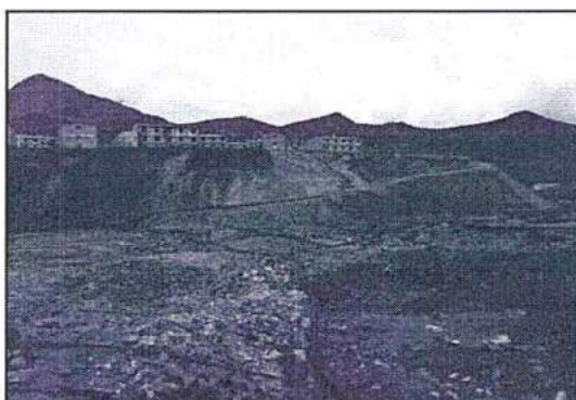
Fotografía N° 72 del Informe de Supervisión: Zona disturbada con afloramiento de aguas ácidas frente a Túnel Victoria Nv 330-PAMA
