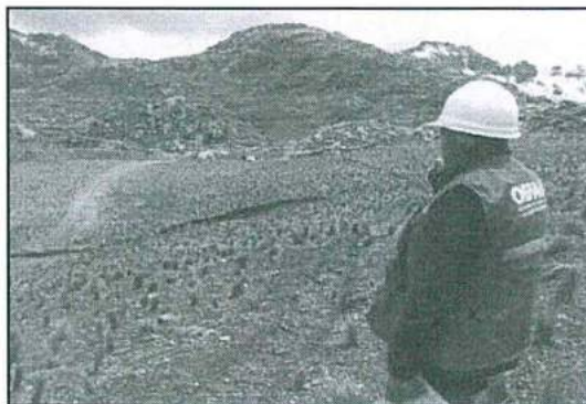
Fotografía N° 26 del Informe de Supervisión: Vista del tajo cerrado Éxito, un canal de derivación que cruza el tajo y al fondo un área disturbada por erosión.
