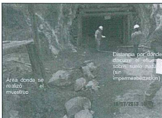
Fotografía N° 27 del Informe de Supervisión: Efluente de la bocamina Túnel Victoria nivel 330 discurrendo por suelo natural.
