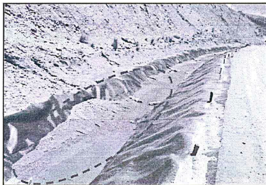
Fotografía N° 55 del Informe de Supervisión: Observación N° 12, Supervisión 2012: Se observan residuos de material por falta de mantenimiento en el canal de coronación.
