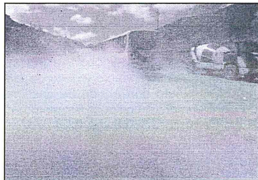
Fotografía N° 40 del Informe de Supervisión: Observación N° 3, Supervisión 2012: Se observa generación de material particulado (polvo) por el paso de los vehículos en la carretera aledaña a la Bocamina del Nivel 500.
