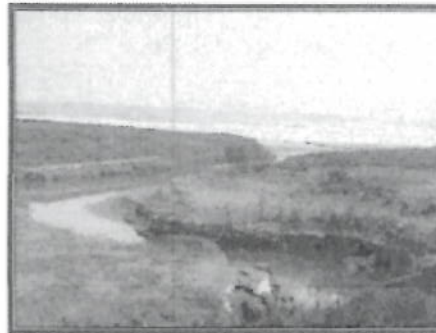
Fotografía V-19: Canal que conduce el efluente final de la planta hacia el mar
