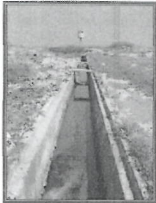
Fotografía V-18: Efluente final de la planta
