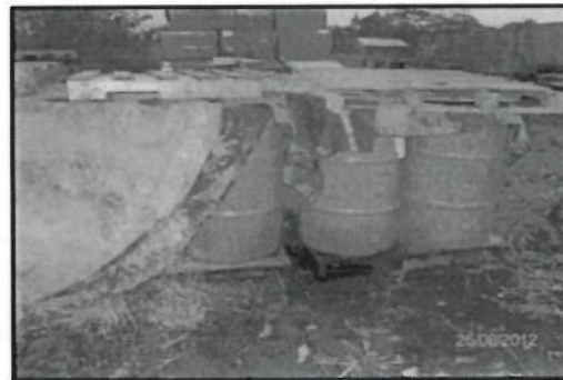
Fotografía N° 66: Vista del centro de almacenamiento de residuos peligrosos del Yacimiento Corrientes . Obsérvese que dicha instalación sobrepasa la capacidad de almacenamiento .
