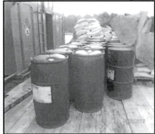
Fotografía N° 29: Plataforma 32X del Yacimiento de Yanayacu, vista de almacenamiento de productos químicos en áreas inadecuadas que no cuentan con sistema de contención de derrame y tampoco se
