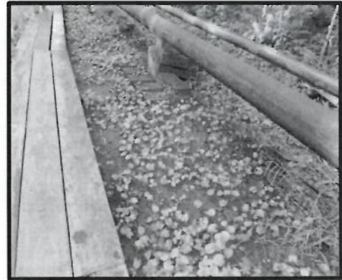
Fotografía N° 13: Vista de suelos afectados con hidrocarburos ubicado en el derecho de vía de ductos entre la Plataforma 60X y la Plataforma 32X del Yacimiento de Yanayacu.
