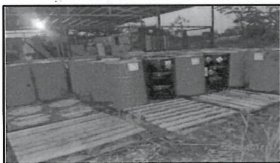
Fotografía N° 64: Vista de almacenamiento de residuos peligrosos (cilindros que contenían lubricantes y productos químicos) almacenados fuera de la instalación del Centro de Almacenamiento del Yacimiento Corrientes . (...)
