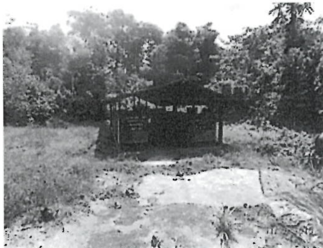
Fotografía Nro. 3: Planta de Compostaje Locación Corrientes para el tratamiento de los residuos orgánicos domésticos
