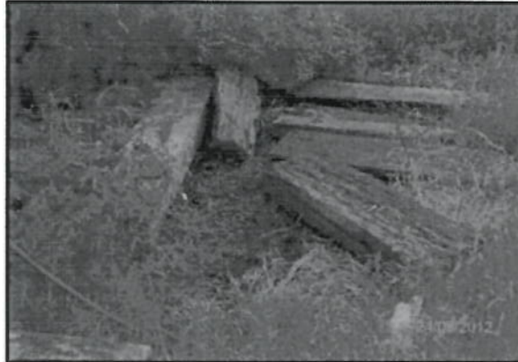
Fotografía N° 27: Vista de suelos afectados con hidrocarburos ubicados debajo de la plataforma del inyector de químicos de la plataforma 32X del Yacimiento Yanayacu.
