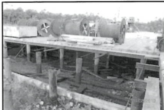
Fotografía N° 24: Vista de suelos afectados con hidrocarburos ubicados en los alrededores de la Plataforma 32X del Yacimiento Yanayacu.
