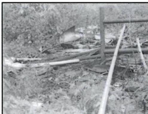
Fotografía N° 43: Vista de suelos afectados con hidrocarburos y maderas impregnadas con hidrocarburos ubicados en los alrededores de la Plataforma 157 del Yacimiento de Chambira (Coordenadas UTM, Sistema WGS 84: 0465988E, 9561953N).
