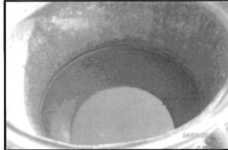
Fotografía N° 15: Plataforma 60X, vista del contenido de los cilindros. Obsérvese el almacenamiento de agua de lluvia afectada con hidrocarburos .
