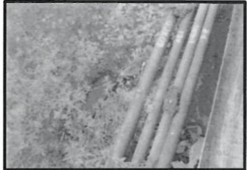
Fotografía N° 11: Vista de suelo afectados con hidrocarburos ubicados en el derecho de vía de ductos entre la plataforma 60X y la Plataforma 32X del Yacimiento de Yanayacu.
