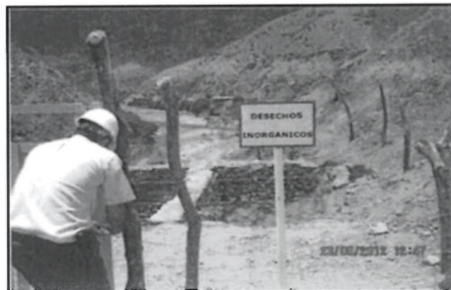
Fotografía N° 8 Descripción: El relleno sanitario de la Estación N° 9 cuenta con una precaria barrera y puerta de seguridad.
