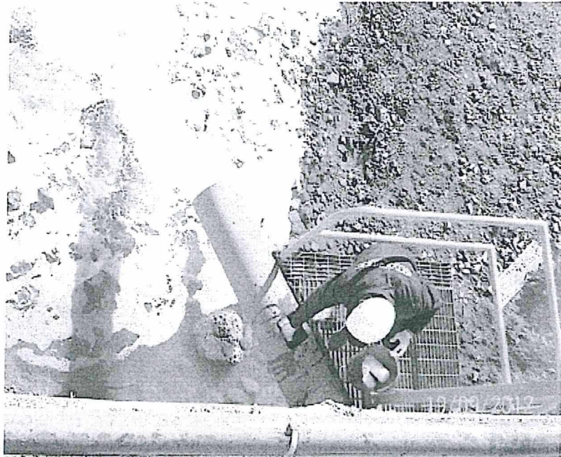
Fotografía N° 101. Efluente industrial: Punto de control "E-09" Descarga de Pozas de Sedimentación al río Huallaga, localizado aguas debajo de la Planta de Beneficio Chicrin.
