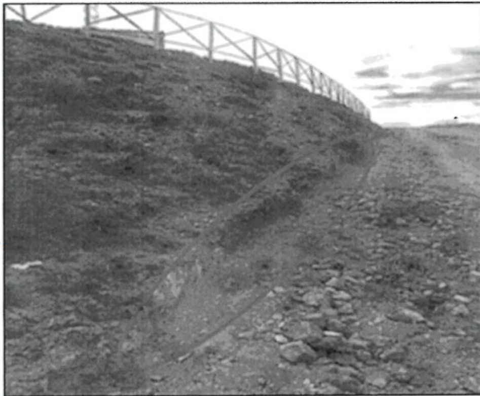
Fotografía N° 9 Accesos hacia el área de logeo
