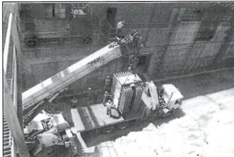
Fotografía N° 1: Traslado de transformador
