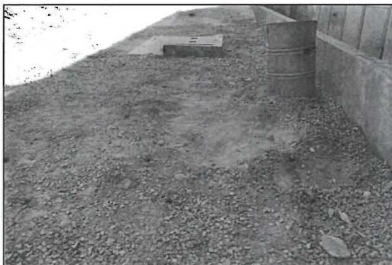
Fotografía N° 5: Remoción de suelo natural contaminado.
