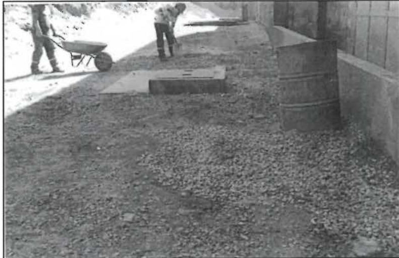
Fotografía N° 6: Reposición con suelo natural
