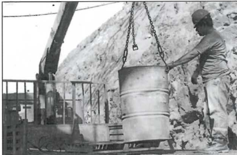
Fotografía N° 7: Transporte a Almacén de Residuos Peligrosos de suelo contaminado.
