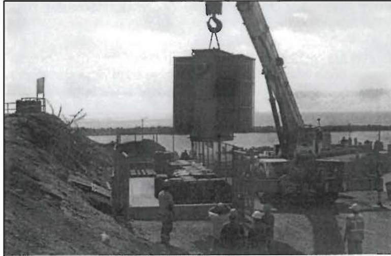
Fotografía N° 2: Colocación de transformador en Almacén de Residuos Peligrosos
