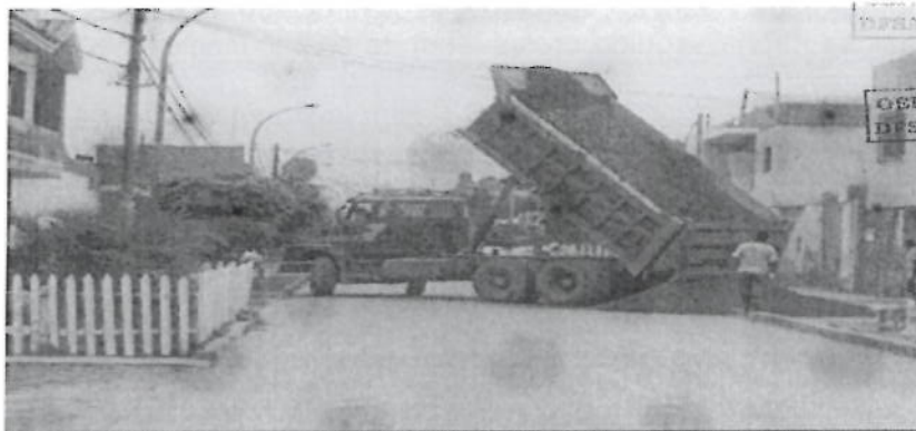
Foto V.2. Descarga de tierra agrícola para el relleno de la calle Pucallpa, Santa Marina.
