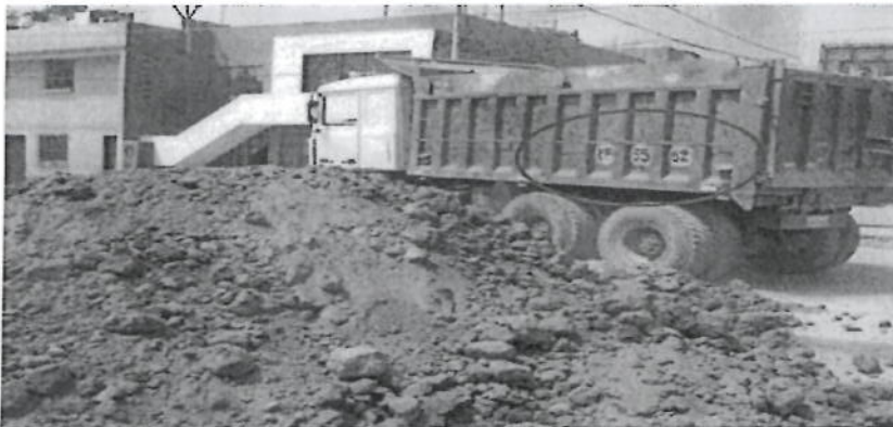
Foto V.1. Descarga de tierra agrícola para el relleno de la calle paralela a la Avenida Rimac. IV Sector.
