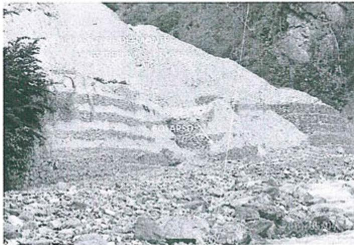
Fotografía 58.- Colapso de algunos sectores del depósito de desmote Estrella I (Hallazgo N° 3).
