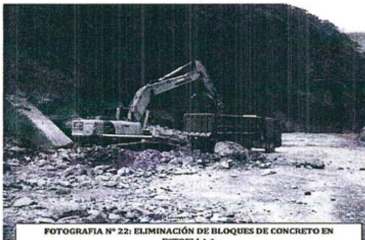
FOTOGRAFIA N° 22: ELIMINACIÓN DE BLOQUES DE CONCRETO EN ESTRELLA 1
