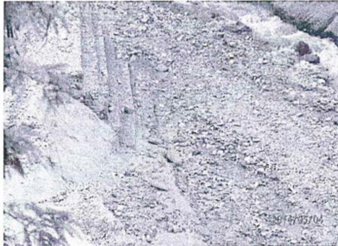
Fotografía 59.- Colapso de algunos sectores del depósito de desmonte Estrella I (Hallazgo N° 3).
