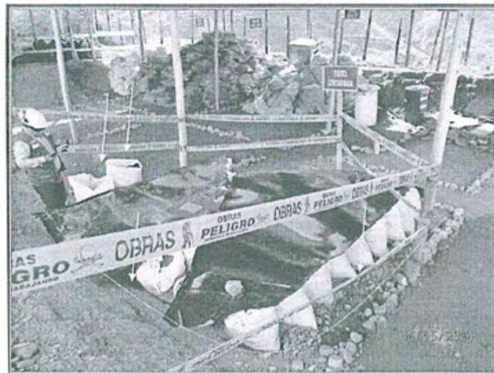
Fotografía N° 32: Hallazgo N°1. Se observa la falta de revestimiento e impermeabilización de la celda donde se ubica el material contaminado con Hidrocarburo ubicado en las coordenadas (Datum WGS 84) N9158481, E806857
