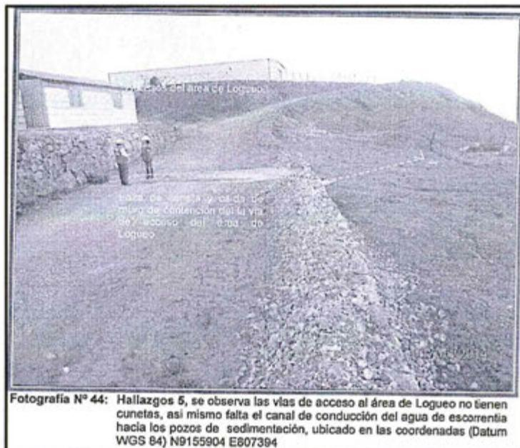
**Fotografía N° 44:** Hallazgos 5, se observa las vías de acceso al área de Logeo no tienen cunetas, así mismo falta el canal de conducción del agua de escorrentía hacia los pozos de sedimentación, ubicado en las coordenadas (Datum WGS 84) N9155904 E807394
