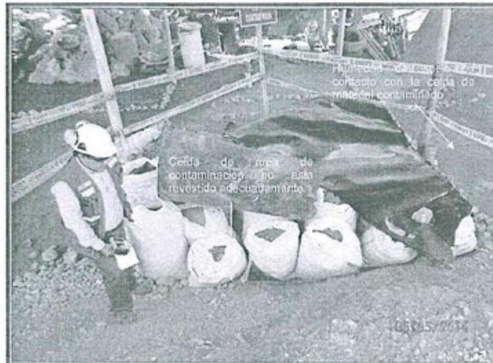
Fotografía N° 31: Hallazgo N° 1. Se observa la celda de material contaminado sin una adecuada impermeabilización. En las coordenadas (Datum WGS 84) N9158481, E806857
