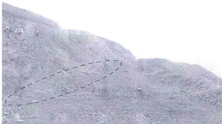
Foto 13. Zona de derrumbamiento de material desde el talud (circulo)
