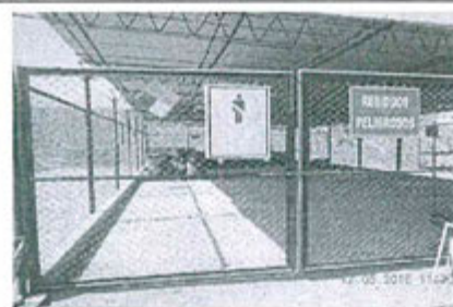
Fotografía N° 2: Vista exterior del punto de acopio de RRSS peligrosos
