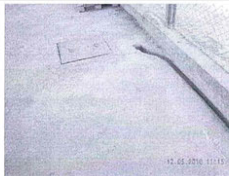
Fotografía N° 6: Vista de la canaleta de descarga del sistema de drenaje.
