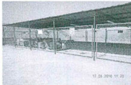
Fotografía N° 1: Vista exterior del punto de acopio de RRSS peligrosos
