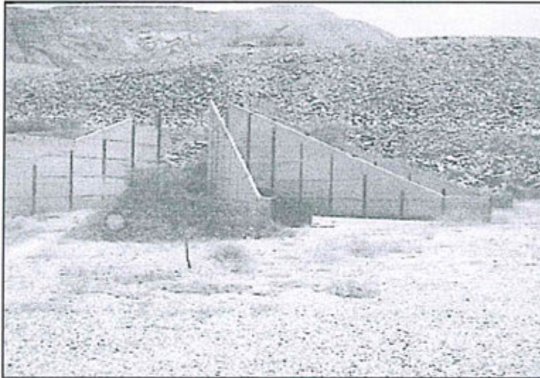
Vista 11. Paredes de concreto y área deforestada
